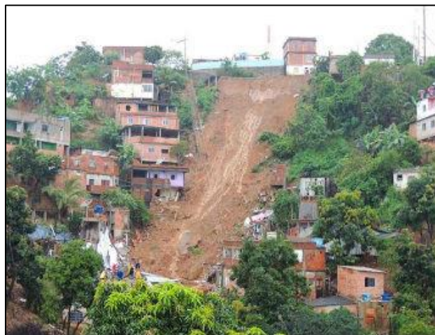
Figura 1: Deslizamento de terra em Colatina durante as chuvas de dezembro de 2013.
