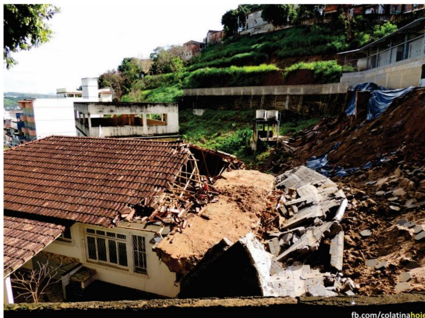
Figura 19: Deslizamento em Colatina - Dezembro de 2013. Fonte: Site fb.com/colatinahoje .
