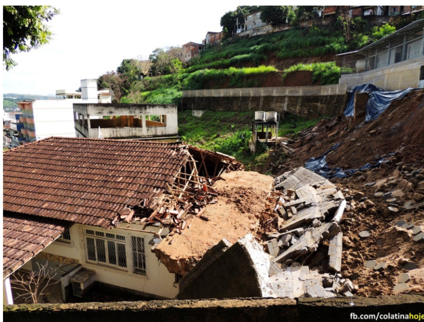
Deslizamento em Colatina - Dezembro de 2013. Fonte: fb.com/colatinahoje.
