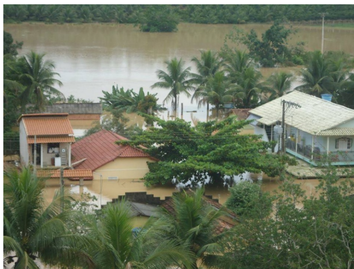
Inundação em São Domingos do Norte - Dezembro de 2013. Fonte: CEPDEC/ES.
