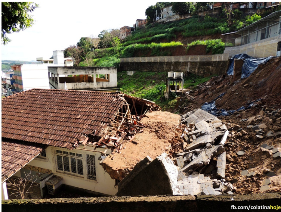
Deslizamento em Colatina - Dezembro de 2013.
