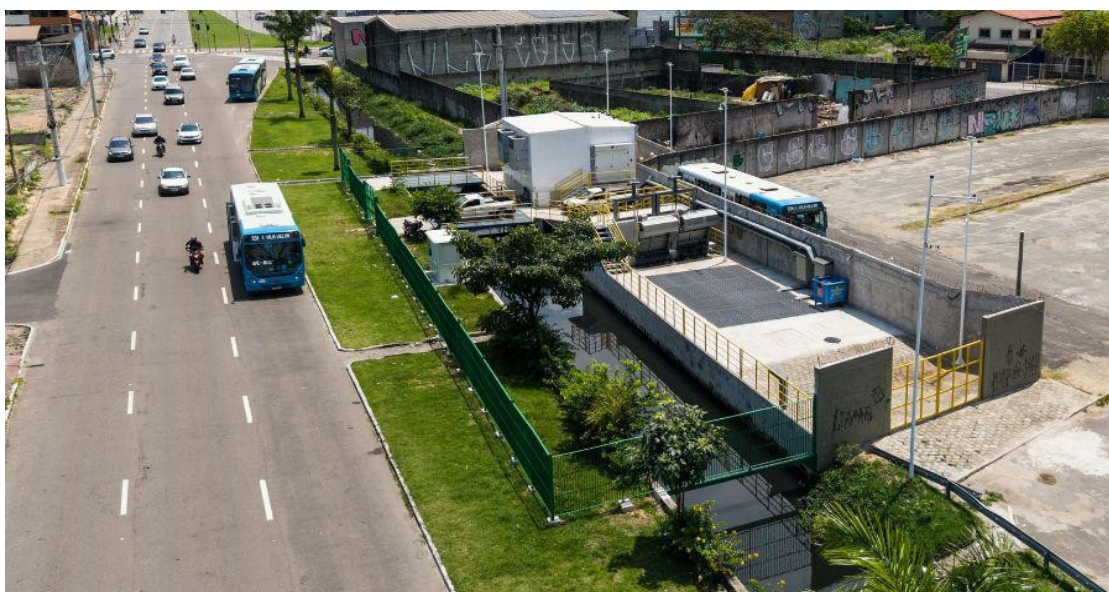
Foto 14: Estação de Bombeamento de Águas Pluviais Bigossi. Crédito: Comunicação/SEDURB
