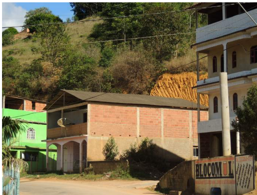
Foto 45 – Taludes de corte com alturas acima de 5,0m.
