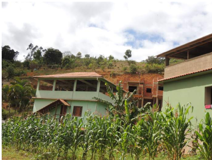
Foto 15 – Vista frontal do setor de risco.
