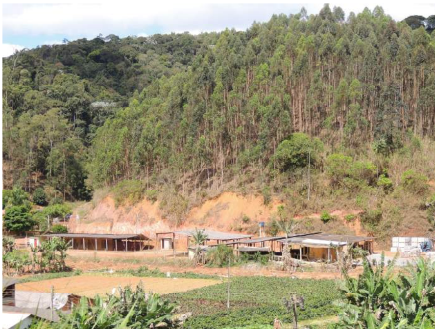
Foto 30 – Indícios de instabilidade ao longo da encosta.
