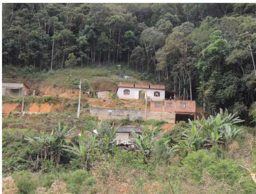
Foto 18 - Vista aproximadamente exemplificando a tipologia de ocupação.
