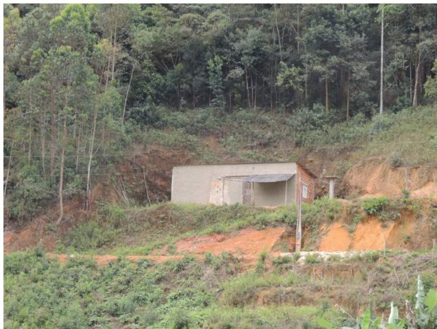
Foto 17 – Vista aproximadamente exemplificando a tipologia de ocupação.
