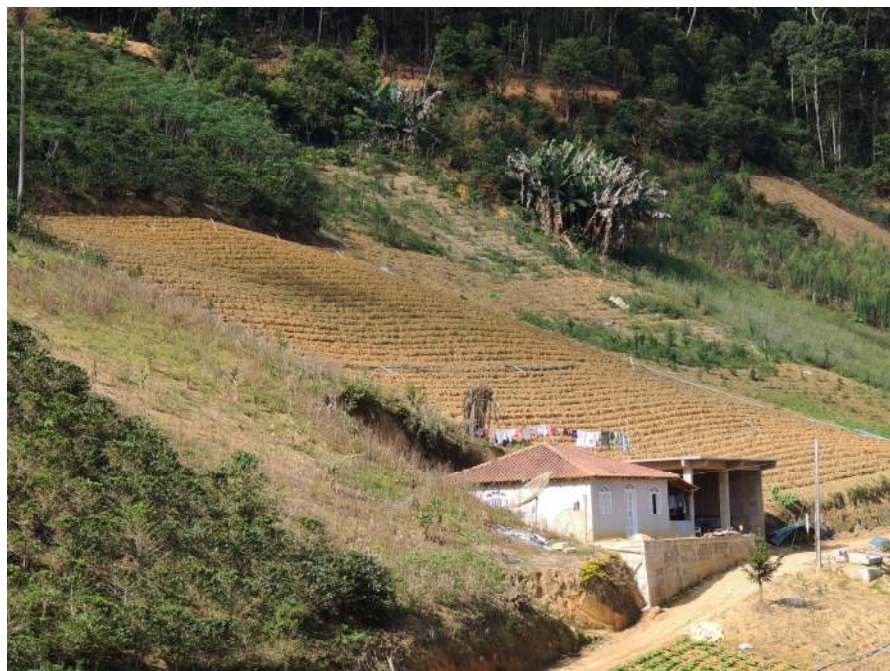
Foto 48 – Talude de corte não estabilizado.
