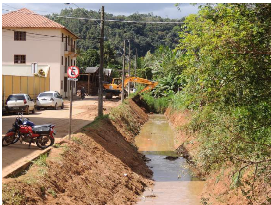
Foto 31 – Canal após processo de limpeza.
