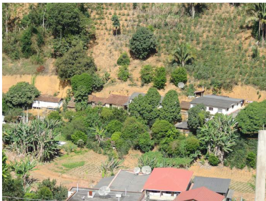
Foto 36 - Domicílio de baixo padrão construtivo e cortes verticais no talude.
