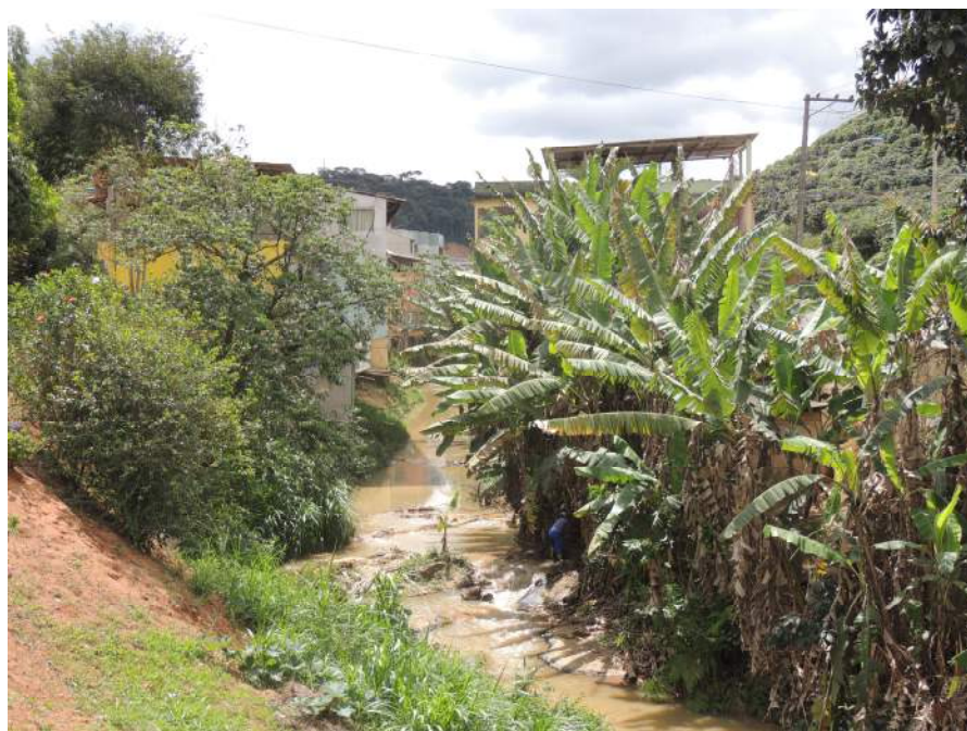
Foto 54 – Trecho final do canal na área da sede. Suscetibilidade a ocorrência de enxurradas e solapamentos e ocupação das margens.
