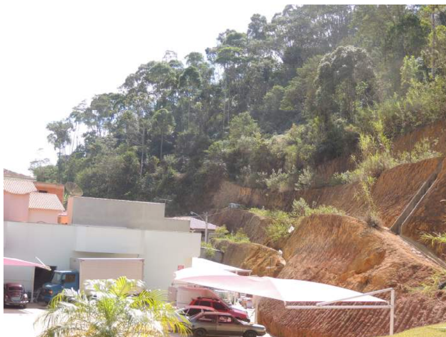
Foto 27 – Trecho complementar do setor de risco.
