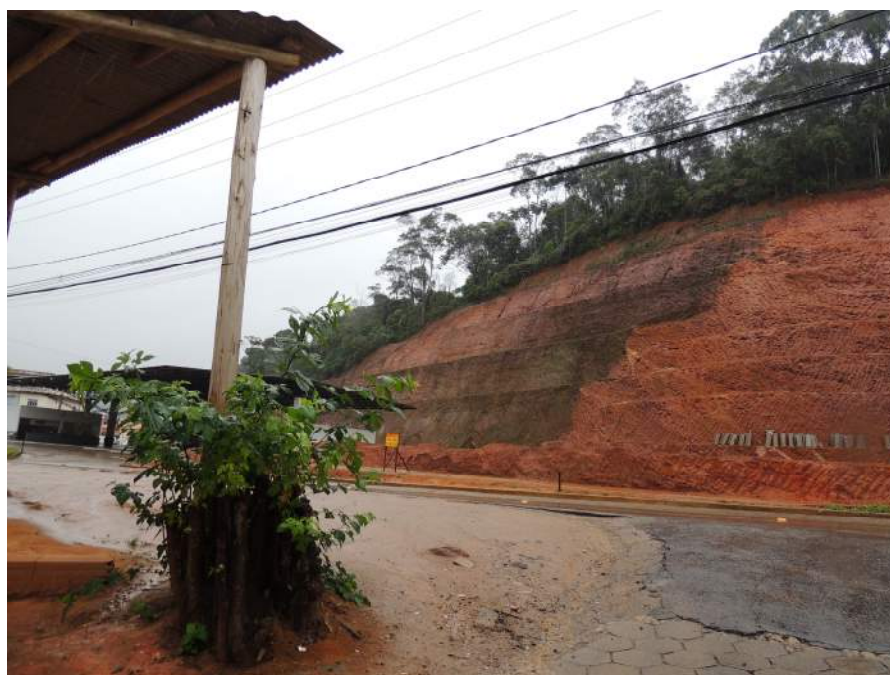
Foto 21 – Encosta próxima a rodoviária sendo retalhada.
