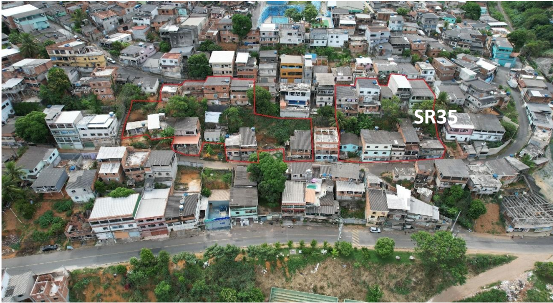
Figura 70 – Delimitação espacial do Setor de Risco sobre uma imagem obliqua de março de 2023.
