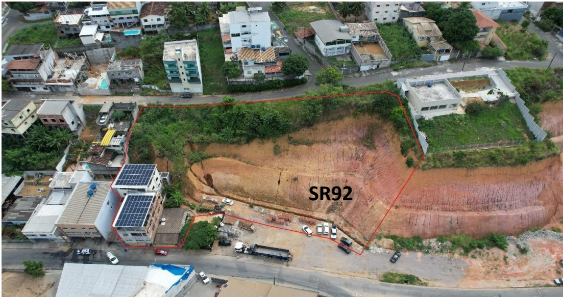
Figura 150 – Delimitação espacial do Setor de Risco sobre uma imagem obliqua de março de 2023.
