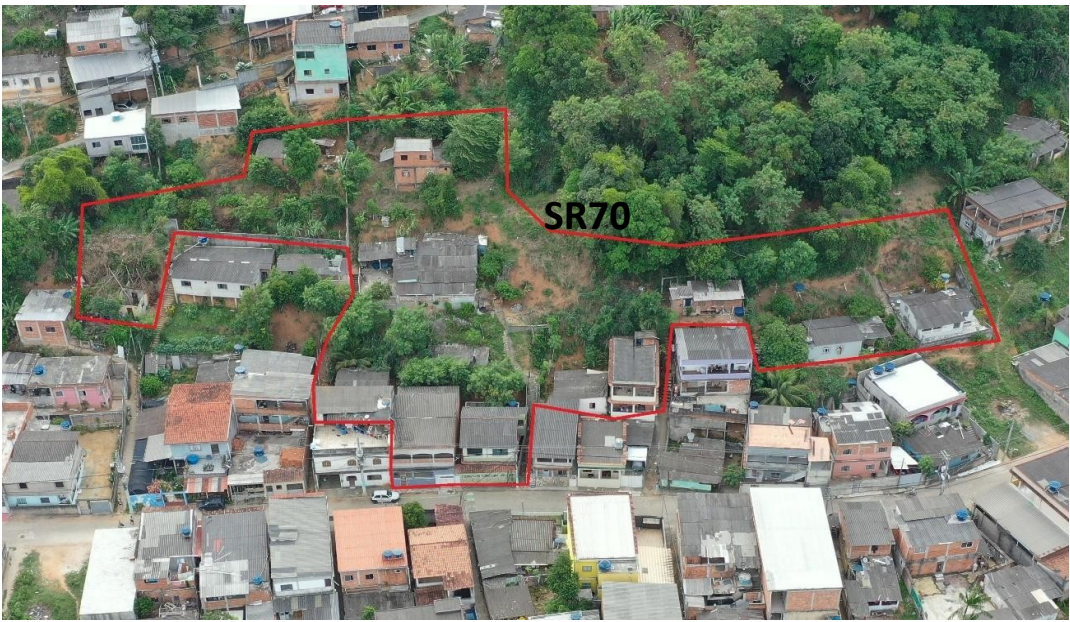
Figura 41 – Delimitação espacial do Setor de Risco sobre uma imagem obliqua de março de 2023.
