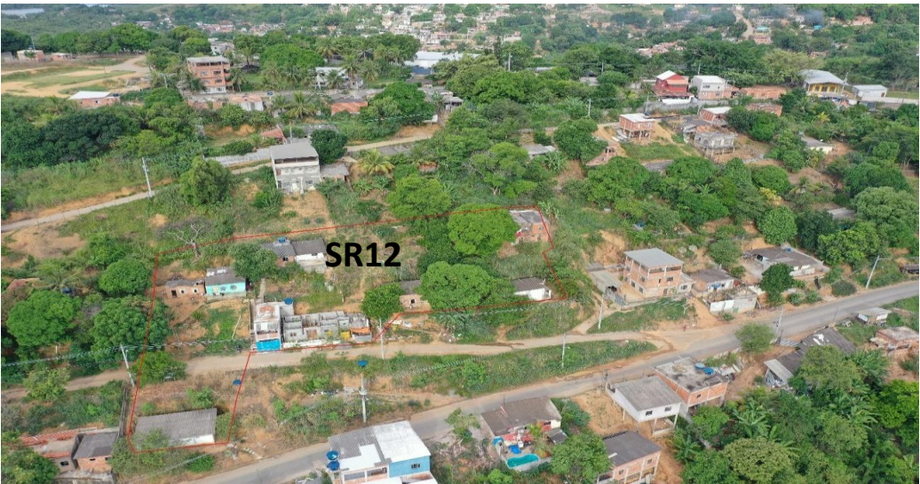
Figura 18 – Delimitação espacial do Setor de Risco sobre uma imagem obliqua de março de 2023.
