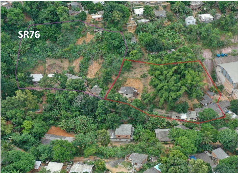
Figura 126– Delimitação espacial do Setor de Risco sobre uma imagem obliqua de março de 2023.
