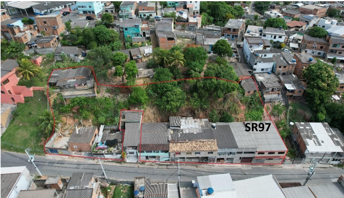
Figura 160 – Delimitação espacial do Setor de Risco sobre uma imagem obliqua de março de 2023.
