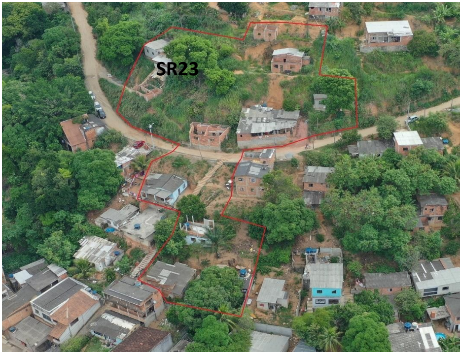
Figura 37 – Delimitação espacial do Setor de Risco sobre uma imagem obliqua de março de 2023.
