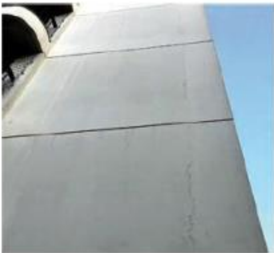
Figura 8 – Destacamentos entre alvenaria e estrutura, provocados por movimentações térmicas diferenciadas
