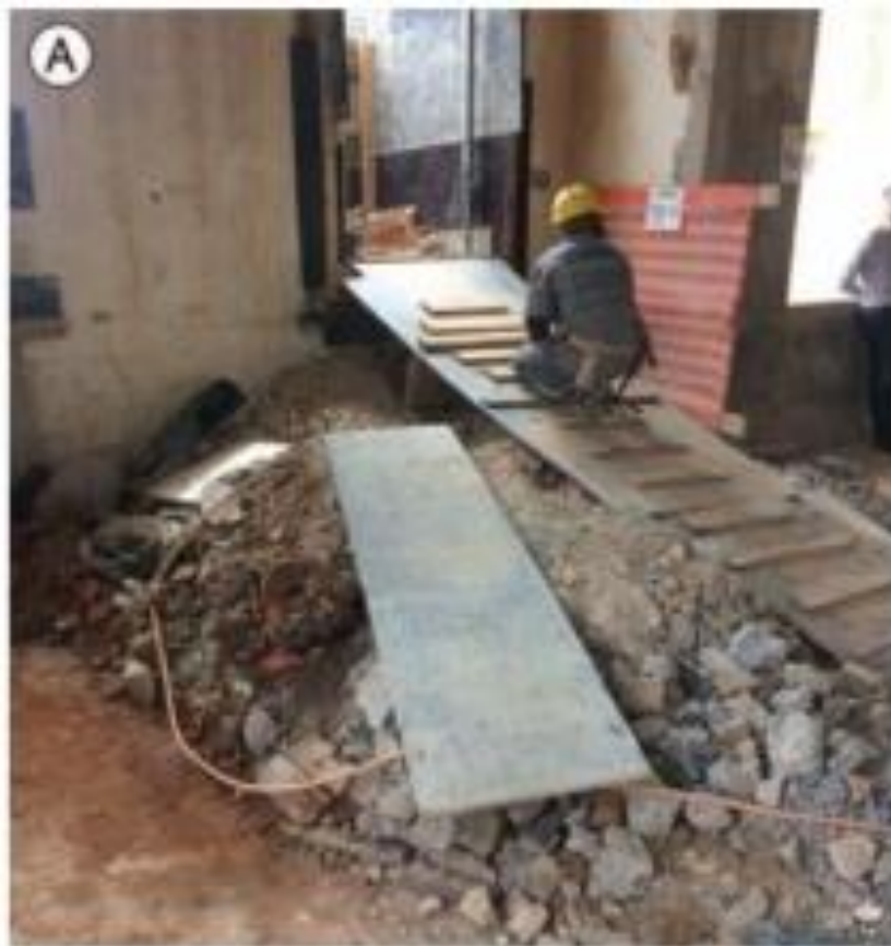
Figura 50 – Prédio em fase de reforma: (A) sobrecarga no andar superior e (B) fissuras importantes na alvenaria de tijolos do andar abaixo
