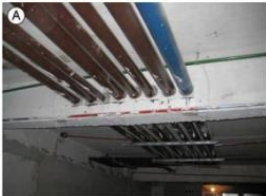
Figura 39 – (A) Furos de passagem muito próximos e (B) corte de estribos do pilar para o acoplamento das armaduras da viga
