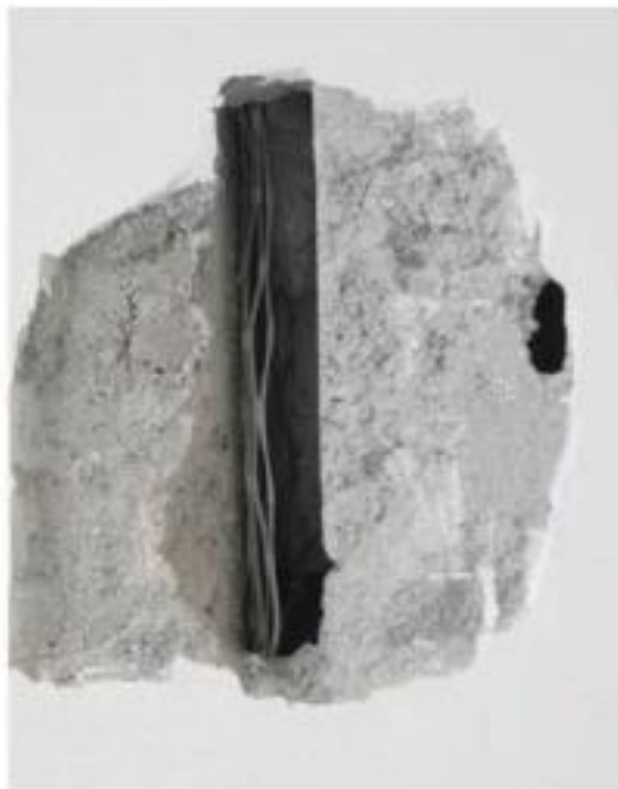
Figura 75 – Tela encurvada na posição da junta de assentamento e tela que não foi introduzida na alvenaria no encontro com o pilar – ambas sem nenhuma função
