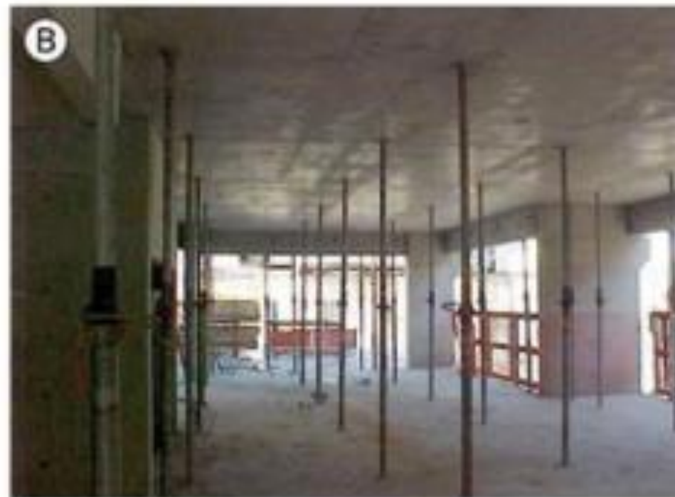
Figura 40 – (A) Sobrecarga em laje do térreo recém-executada (teto de subsolo) e (B) reposicionamento de escoras após desenforma da laje (“reescoramento”, praticamente inútil)
