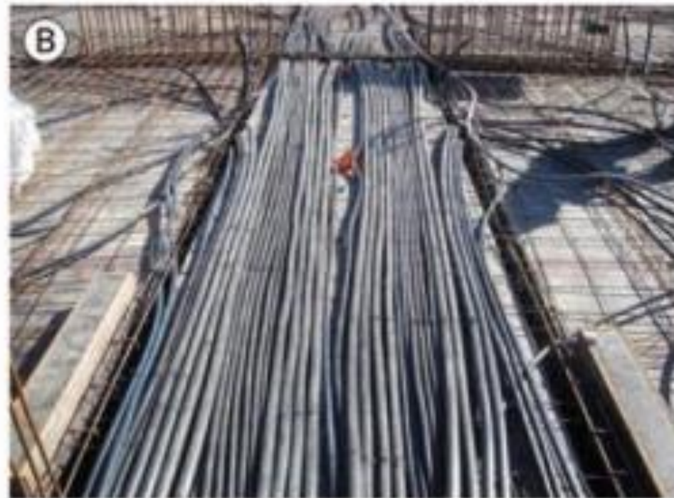
Figura 38 – (A) Congestionamento de armaduras e (B) congestionamento em “concreto armado com eletrodutos”
