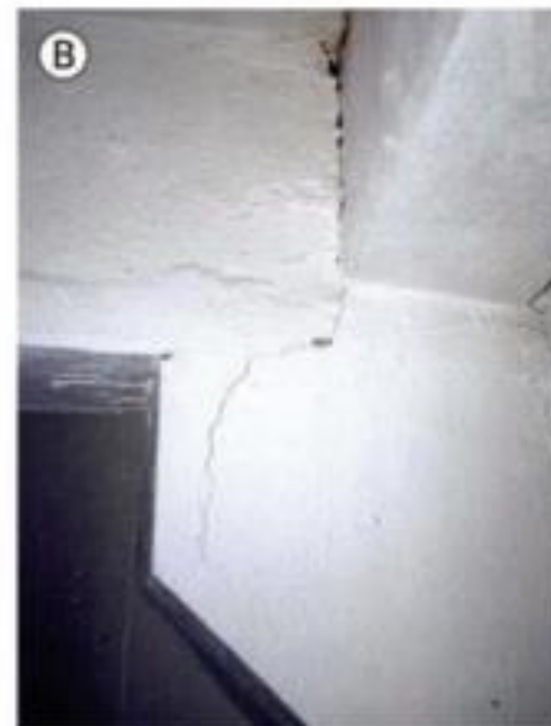
Figura 45 – Fissuras e lascamentos nas extremidades de (A) consolo pré-moldado e (B) consolo moldado no local, por concentração de tensões
