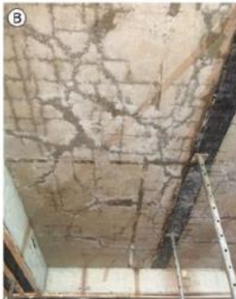
Figura 102 - Fissuras de retração em laje com elevado consumo de cimento ocorridas ainda sob o processo de cura: (A) topo da laje e (B) base da mesma laje
