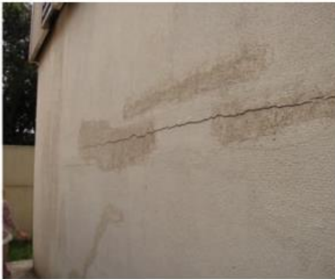
Figura 56 – Fissuras em alvenaria do pavimento térreo decorrentes de flecha na viga de fundação
