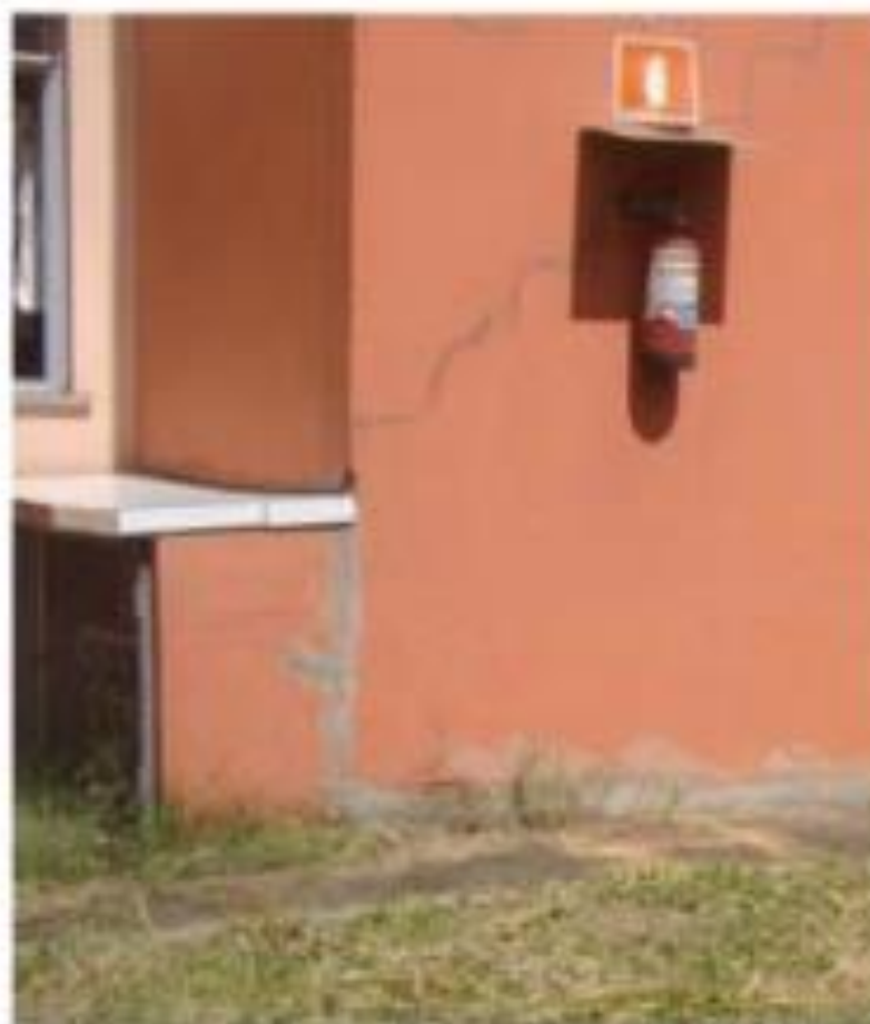
Figura 55 – Fissuras em alvenarias do pavimento térreo decorrentes de flechas em vigas baldrame
