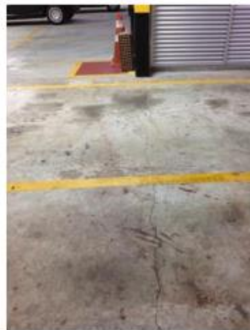
Figura 44 – Fissuras devidas à insuficiência de armadura negativa, problema comum em lajes de subsolos
