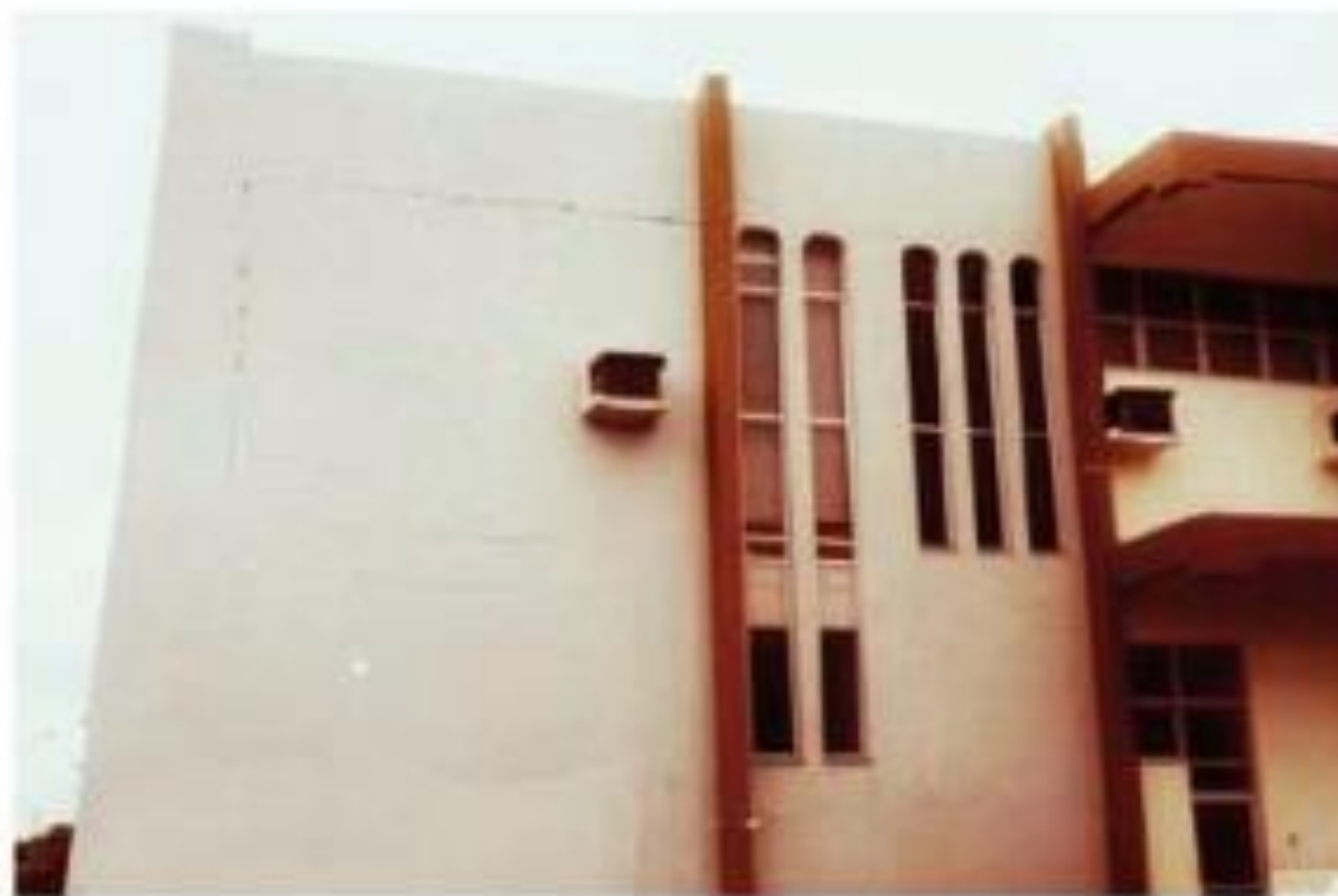
Figura 8 – Destacamentos entre alvenaria e estrutura, provocados por movimentações térmicas diferenciadas
