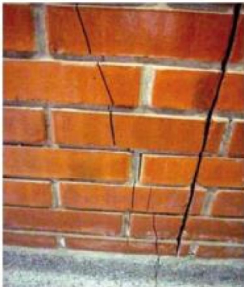
Figura 55 – Fissuras em alvenarias do pavimento térreo decorrentes de flechas em vigas baldrame
