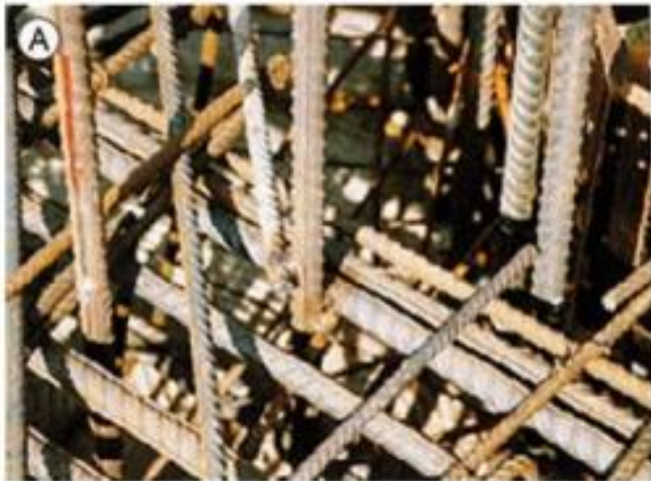
Figura 38 – (A) Congestionamento de armaduras e (B) congestionamento em “concreto armado com eletrodutos”
