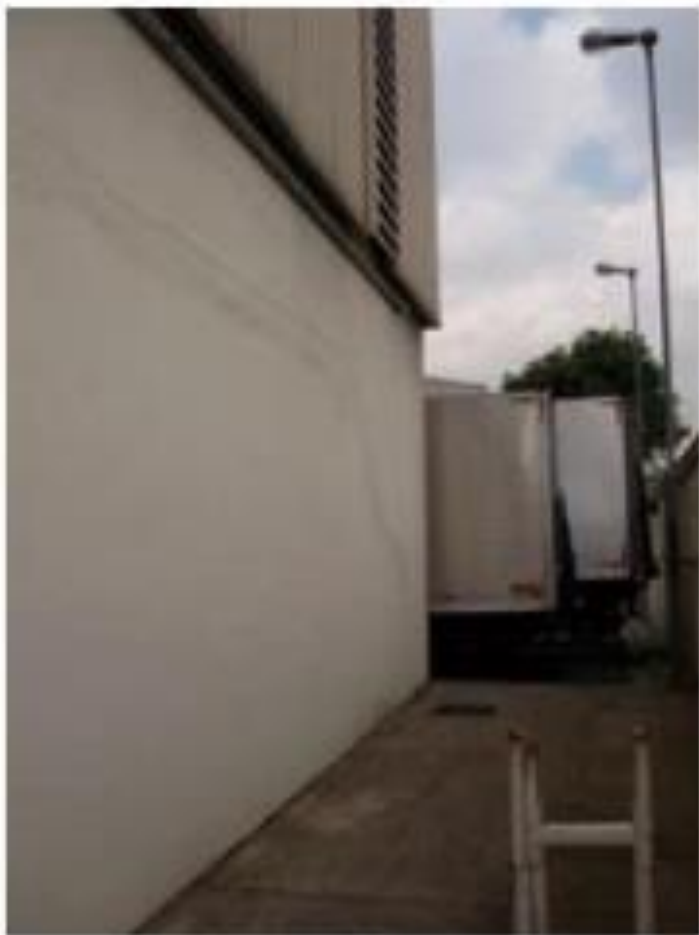
Figura 56 – Fissuras em alvenaria do pavimento térreo decorrentes de flecha na viga de fundação
