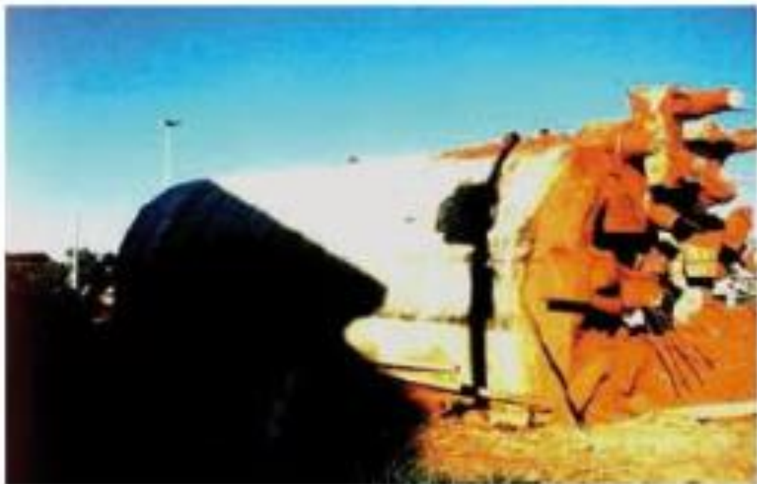
Figura 97 - Reservatórios tombados em razão de amolecimento do solo por vazamento de água, conjugado com ação do vento
