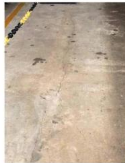
Figura 44 – Fissuras devidas à insuficiência de armadura negativa, problema comum em lajes de subsolos
