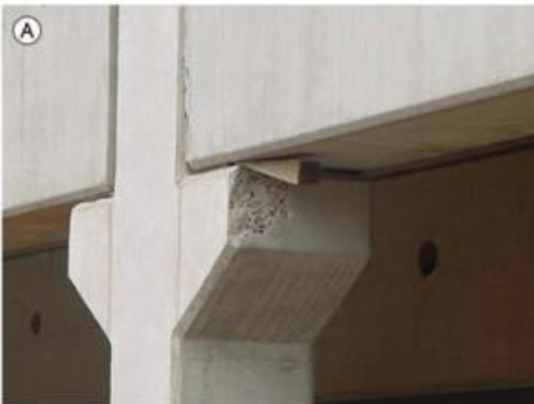
Figura 45 – Fissuras e lascamentos nas extremidades de (A) consolo pré-moldado e (B) consolo moldado no local, por concentração de tensões
