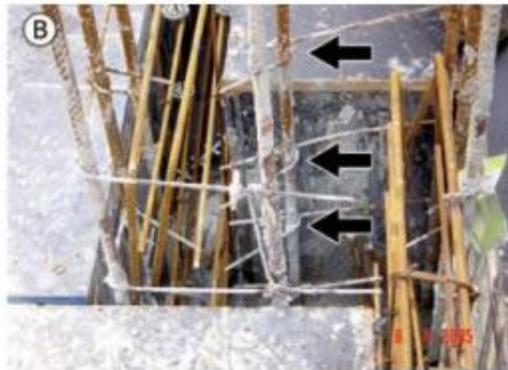
Figura 39 – (A) Furos de passagem muito próximos e (B) corte de estribos do pilar para o acoplamento das armaduras da viga
