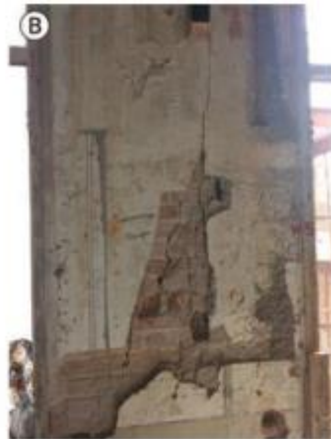
Figura 50 – Prédio em fase de reforma: (A) sobrecarga no andar superior e (B) fissuras importantes na alvenaria de tijolos do andar abaixo
