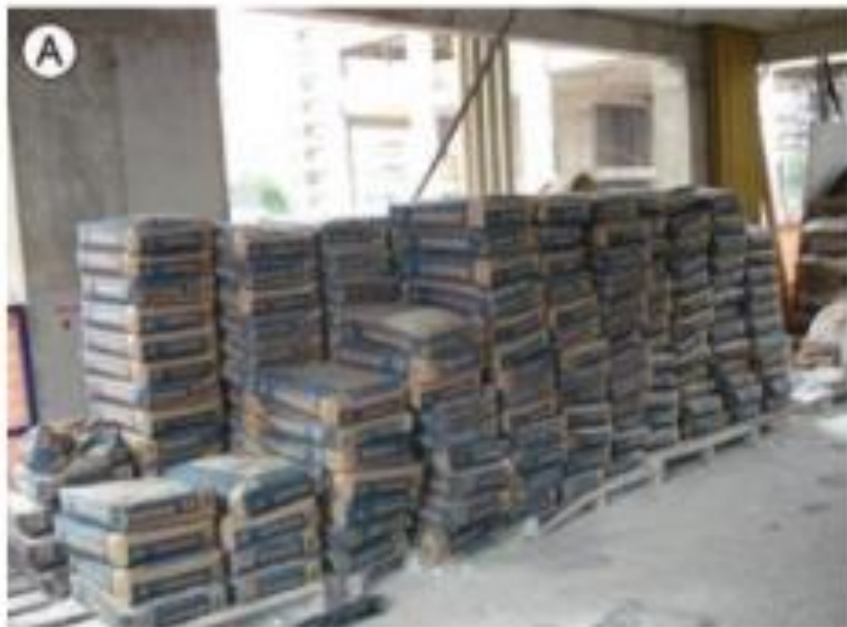
Figura 40 – (A) Sobrecarga em laje do térreo recém-executada (teto de subsolo) e (B) reposicionamento de escoras após desenforma da laje (“reescoramento”, praticamente inútil)
