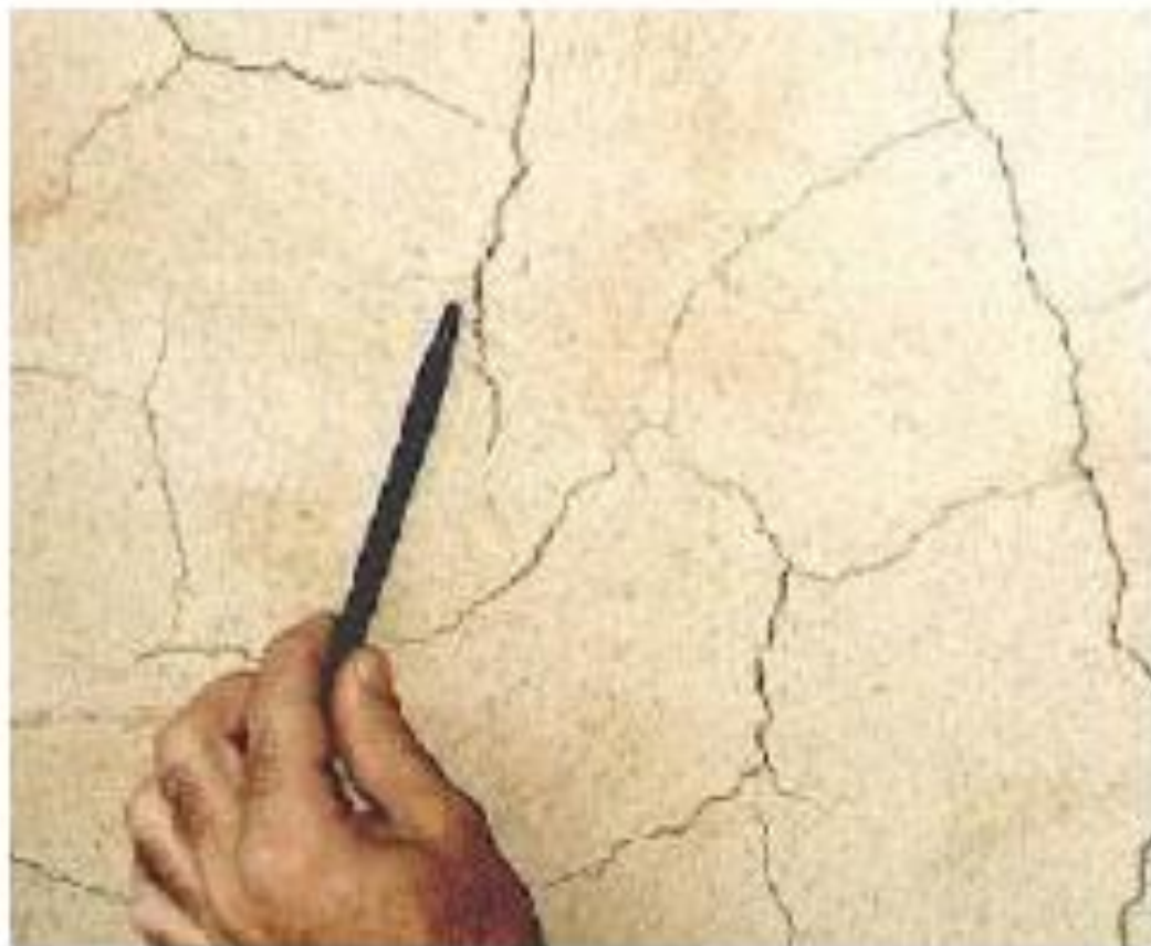
Figura 112 – Fissura de retração da argamassa de revestimento da parede.
