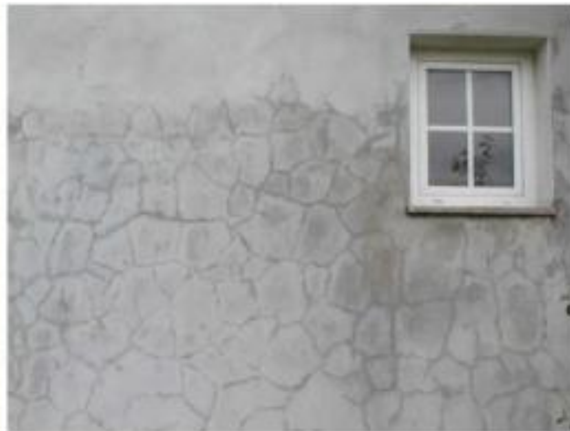
Figura 112 – Fissura de retração da argamassa de revestimento da parede.
