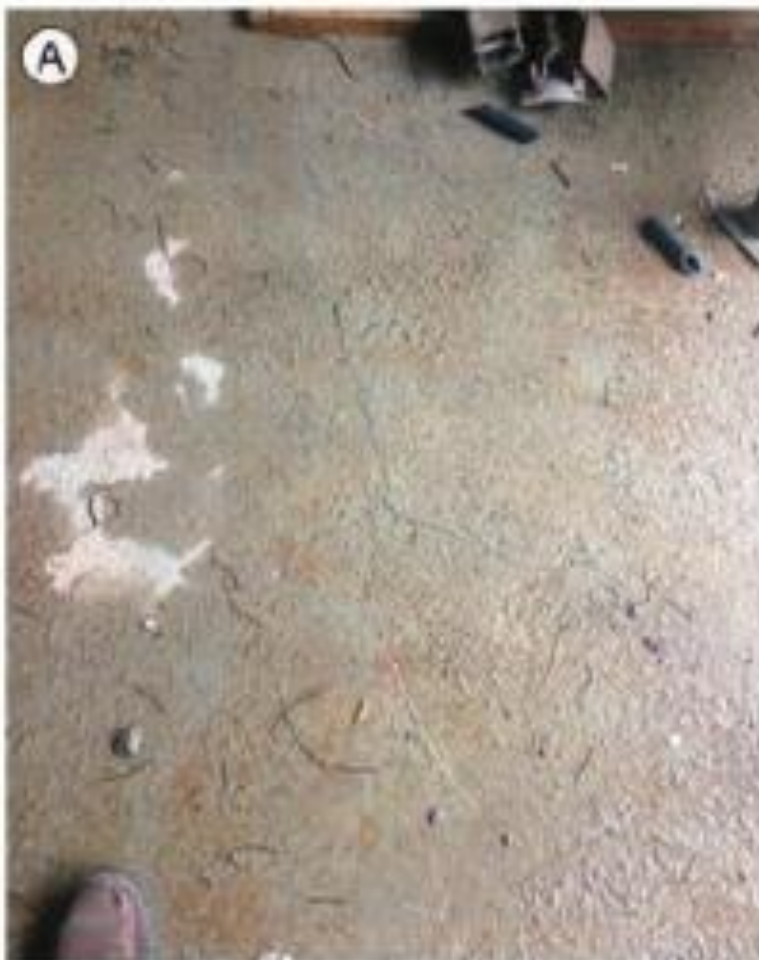
Figura 102 - Fissuras de retração em laje com elevado consumo de cimento ocorridas ainda sob o processo de cura: (A) topo da laje e (B) base da mesma laje
