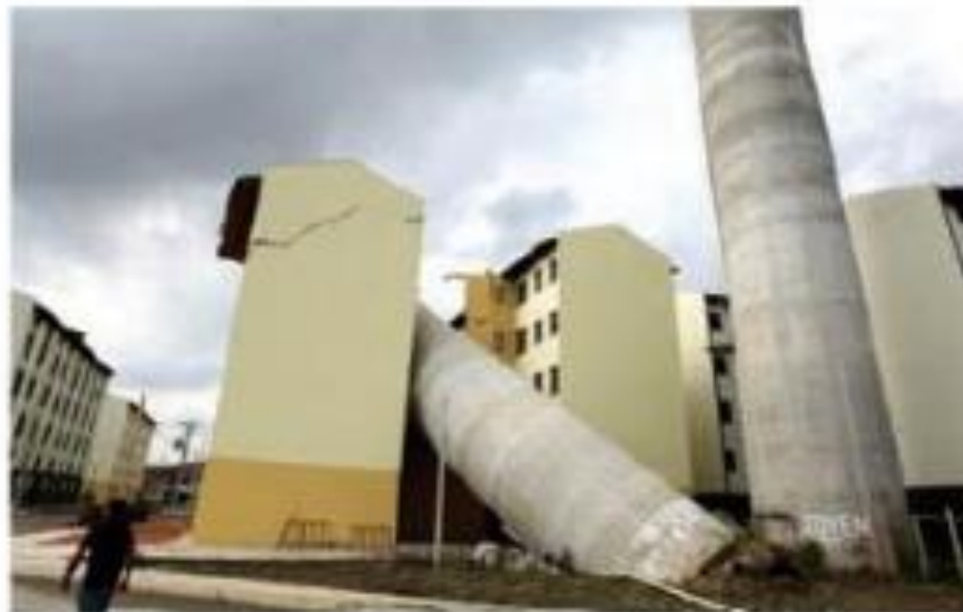
Figura 97 - Reservatórios tombados em razão de amolecimento do solo por vazamento de água, conjugado com ação do vento
