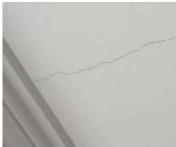
Figura 18 – Fissuras provocadas por movimentação térmica em forro constituído por laje mista
