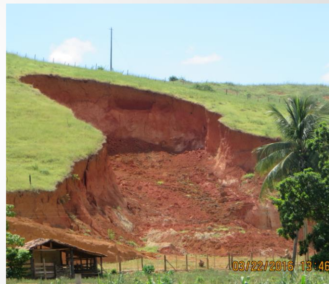
Deslizamento Rotacional - Capitão Andrade – MG
