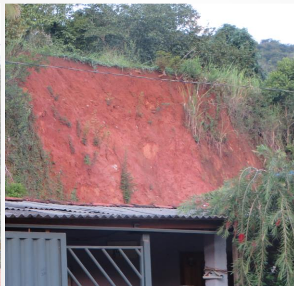
Deslizamento Planar - Antônio Dias - MG
