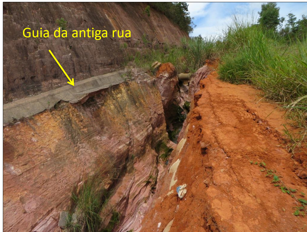
Ravina aberta em rua, com comprometimento de sistema de esgoto. Capelinha – MG. Créditos: Júlio Lana, CPRM/SBG
