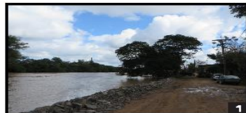
Implantação de enrocamento na margem do rio.
