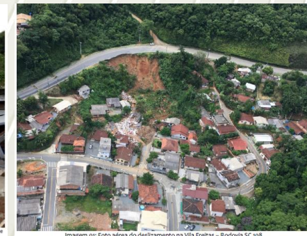
Imagem 01: Foto aérea do deslizamento na Vila Freitas – Rodovia SC 108.
