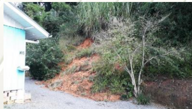
Imagem 17: Deslizamento em talude de corte obstruindo o acesso à garagem.
