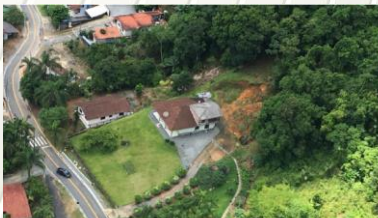
Imagem 32: Foto aérea do deslizamento na Vila Freitas – Rodovia SC 108 – Prefeitura de Guaramirim.
