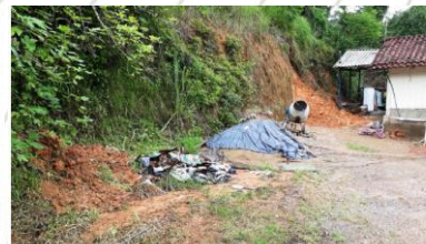
Imagem 10: Deslizamento em talude de corte atingindo a edificação.
