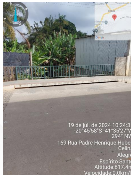
Reconstrução de ponte Alegre
