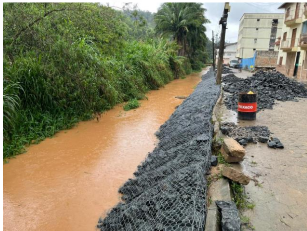
Construção de Gabião Santa Maria de Jetibá
