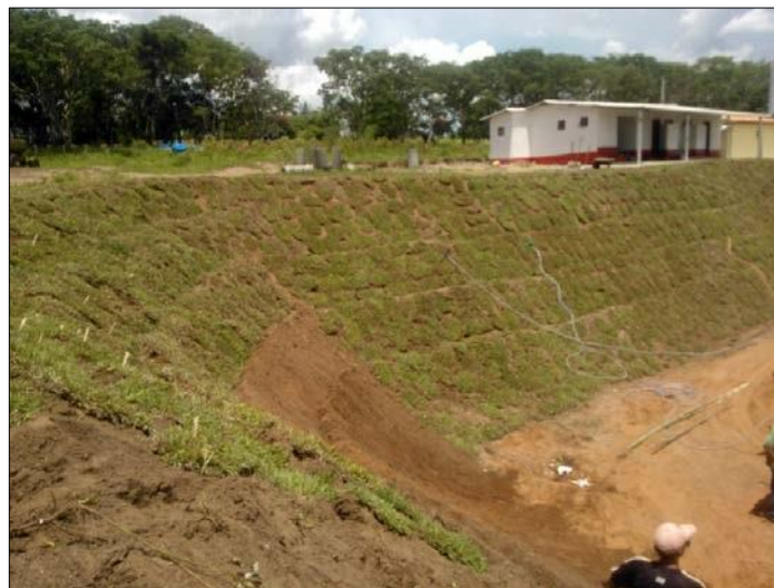
Proteção da face do talude com gramíneas.
