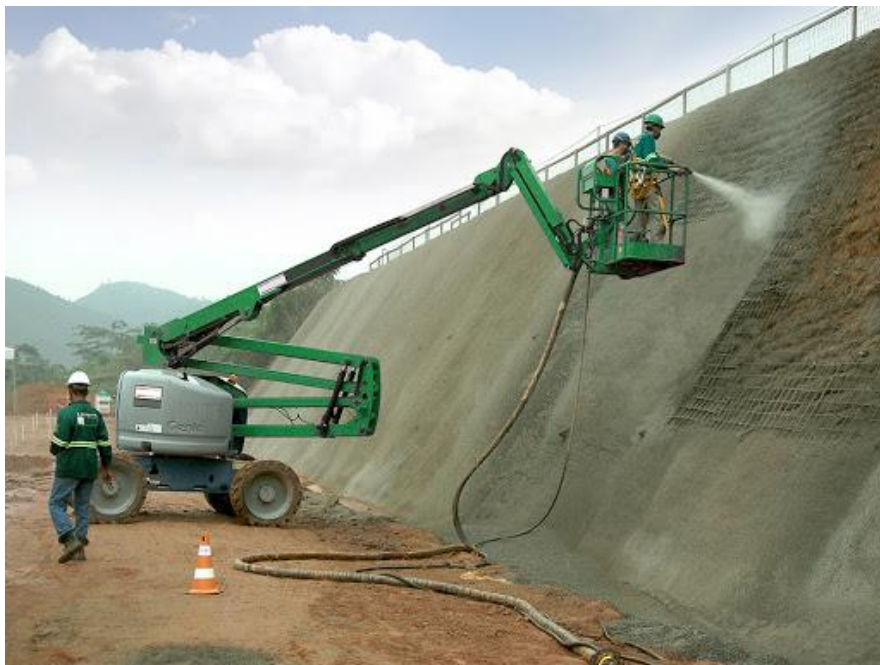
Talude de Contenção Concreto Projetado. Fonte: salotrat.com.br
