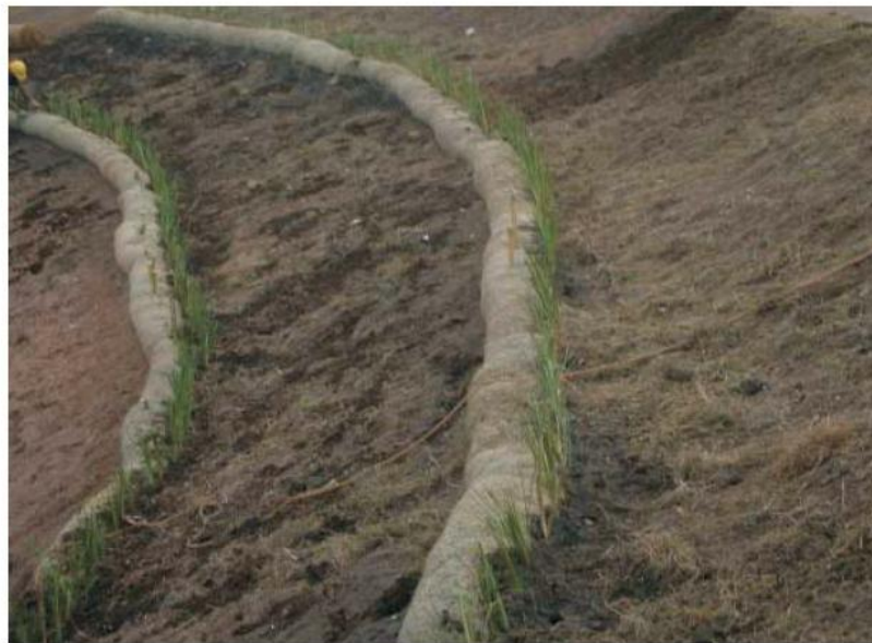
Figura 20 - Exemplo de retentor orgânico de sedimentos do tipo bermalonga associado ao plantio de capim Vetiver sp. fixado de maneira transversal ao sentido de escoamento de água no talude de corte.
