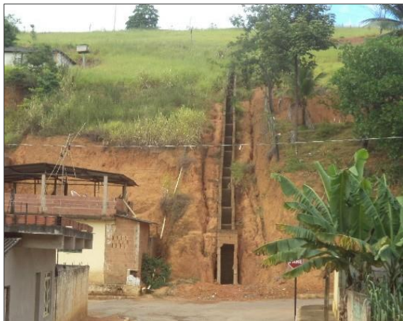
Créditos: Natália Lopes – CPRM/SGB Escada hidráulica com erosão lateral Local: Iapu - MG
