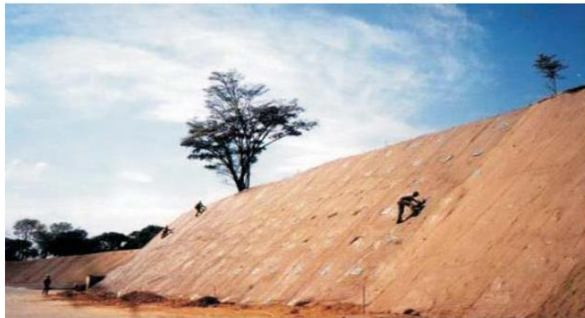
Área recuperada com uso de chumbadores, biomantas antierosivas e malha metálica (solo grampeado). CEMIG-Vespasiano-MG
