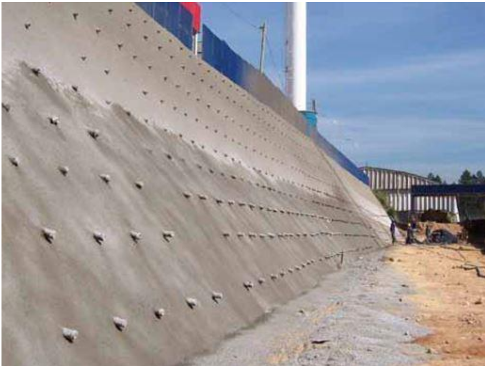
Talude de Contenção em concreto projetado com drenos sub-horizontais profundos.
