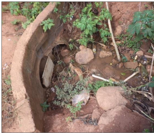
Créditos: Natália Lopes – CPRM/SBG Manifletamento entupido Local: Iapu - MG
