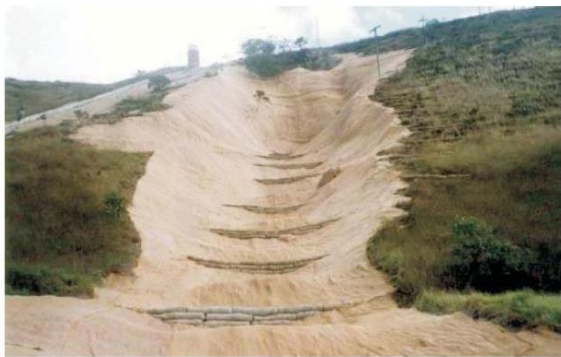
Figura 19 - Disposição das bermalongas perpendicularmente ao sentido do escoamento superficial da enxurrada.
