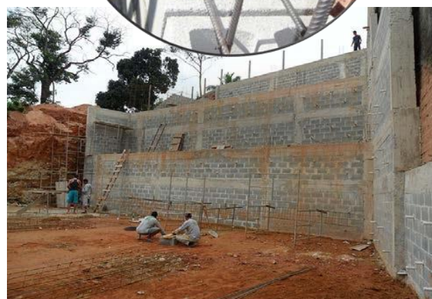
Fonte: projetos.habitissimo.com.br Muro de arrimo
