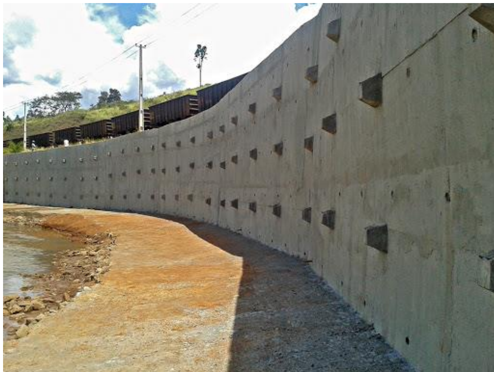
Cortina Atirantada e perfil esquemático. Fonte: solotrat.com.br
