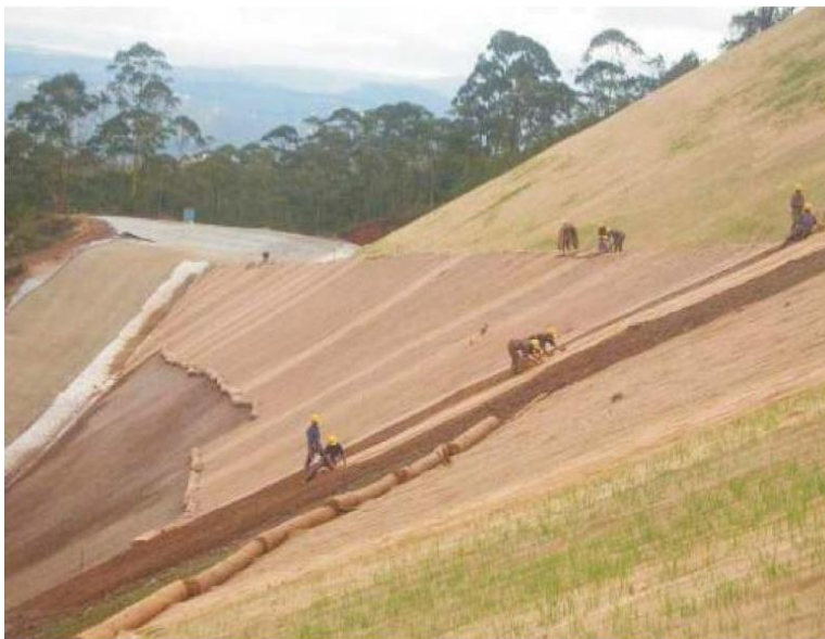
Aplicação das biomantas em talude de corte
