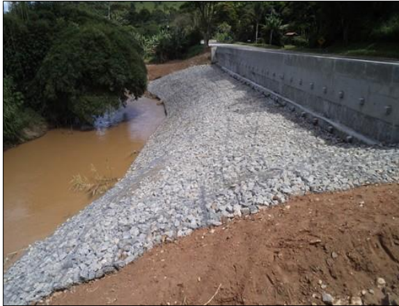
Créditos: SOPE Engenharia Enrocamento contra erosão
