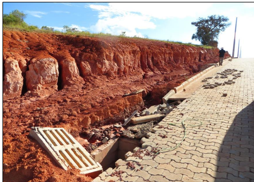
Erosão em via pavimentada, Ouro Preto – MG. Créditos: Júlio Lana, CPRM/SBC
