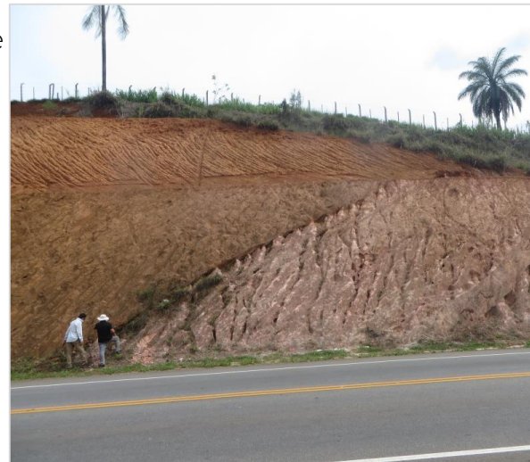
Erosão diferencial entre camadas de rochas alteradas, Material argiloso x material siltoso Nova Lima – MG.
