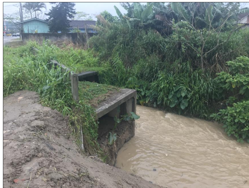
Assoreamento de galeria, Joinville - SC
