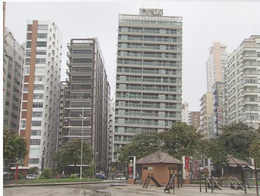
Recalques diferenciais em edificações construídas sobre sedimentos de argilas moles na orla de Santos-SP. (Fonte: Hachich, 1997).
