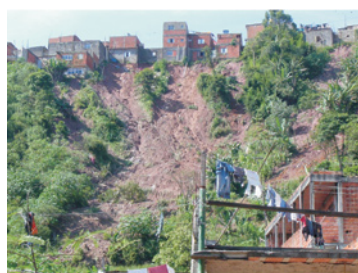
Figura 3.8 – Acidente de escorregamentos planares induzidos pela ocupação.
