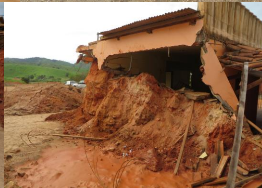
Deslizamento rotacional Itanhomi – MG Abril de 2015
