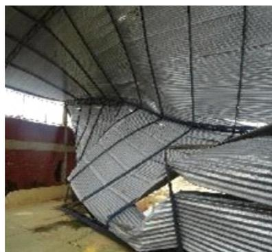
Foto 09: Cachoeiro de Itapemirim - EMEB Waldir Furtado Amorim estrutura metálica do telhado destruída pelo vendaval.
