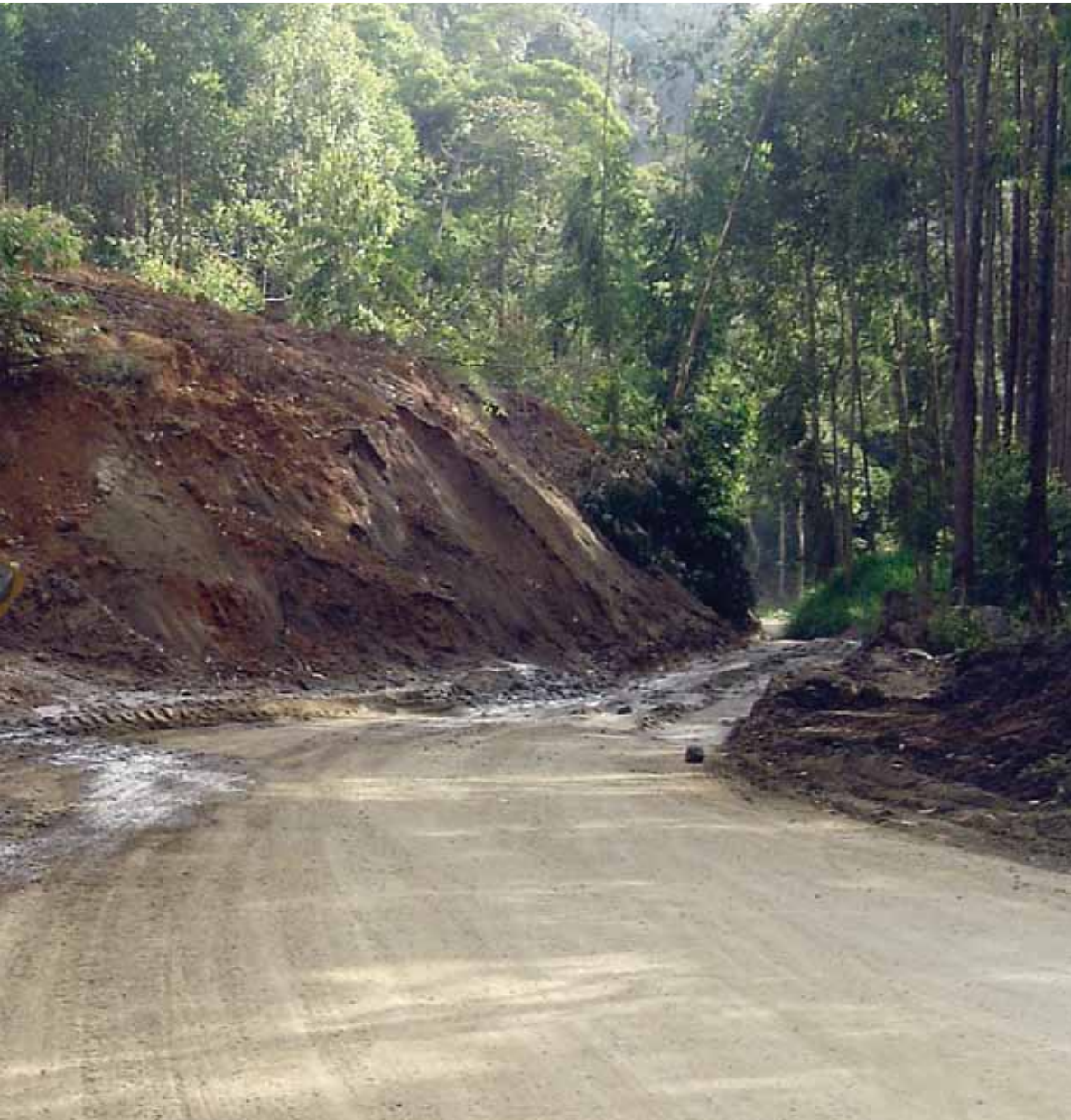
Rodovia ES165 - Afonso Cláudio, novembro de 2006
