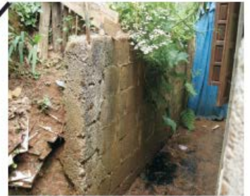
Água minando no talude
