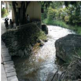
Estreitamento do rio, provocado por construção inadequada
