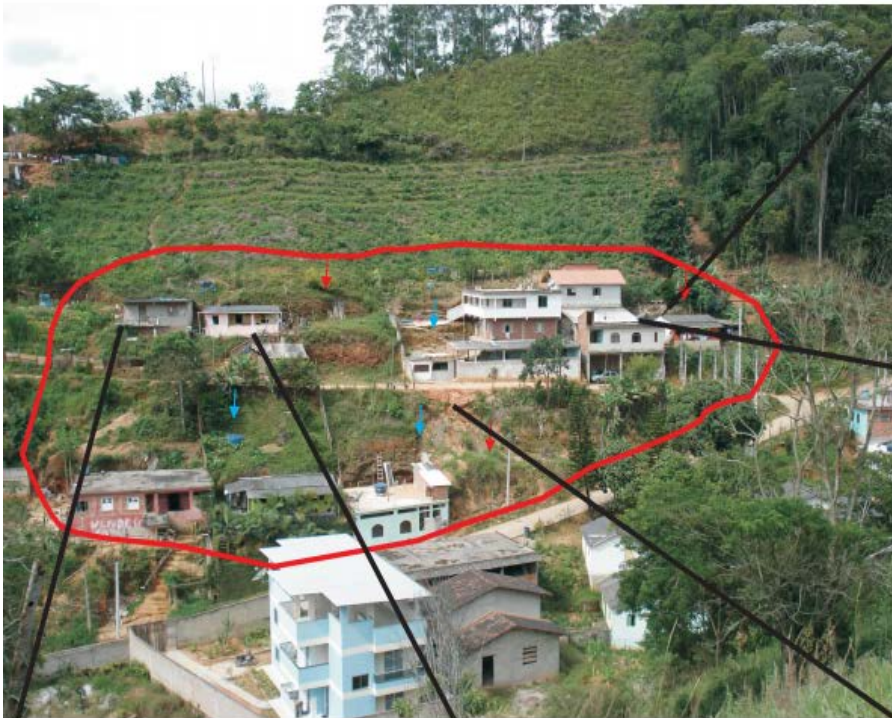
Água minando no talude
