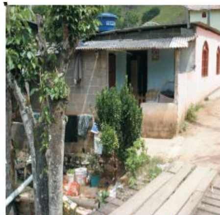
Casa em situação de risco (todo ano sofre danos causados pelas inundações)
