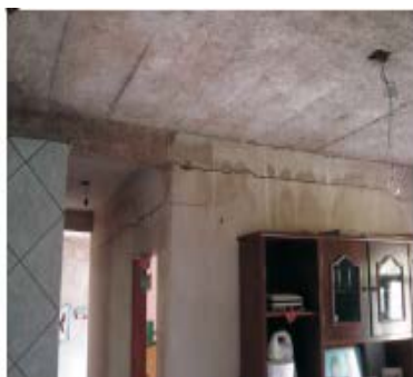
Trincas nas casas
