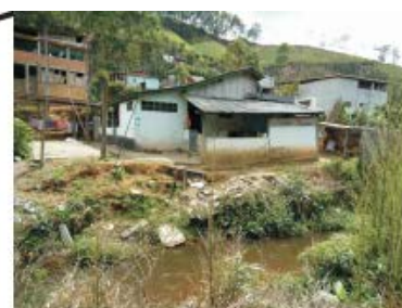
Solapamento da margem do rio
