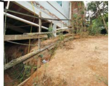
Residência com os alicerces comprometidos
