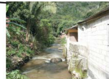
Casas situadas no leito do rio
