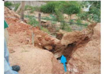
Erosão, proveniente do lançamento de aterro e da falta de drenagem na encosta
