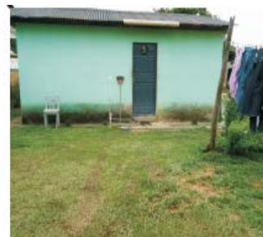
Marca do nível atingido pelas águas
