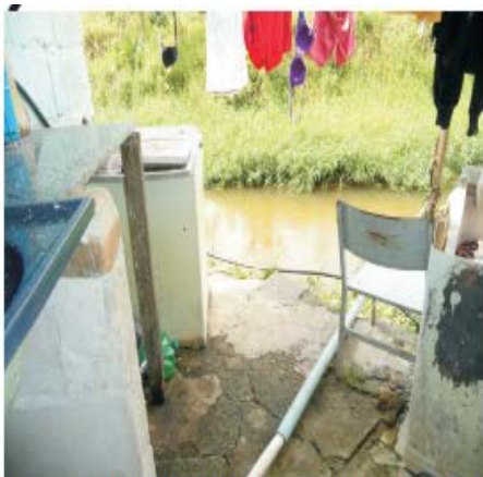
Erosão da margem, danificando estrutura da residência (a casa balança)
