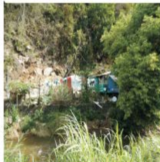
Casas em área de risco: inundação e escorregamento de encosta (solos e blocos de rocha)
