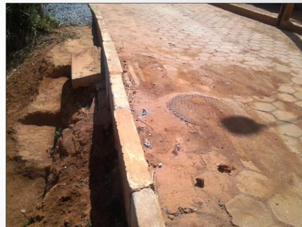
Créditos: Natália Lopes – CPRM/SGB Boca de lobo obliterada Local: Iapu - MG
