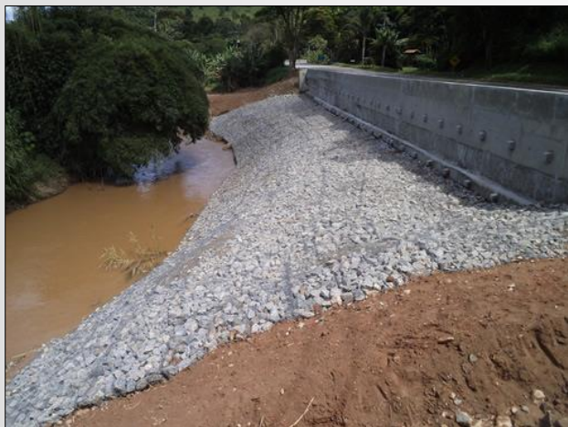
Créditos: SOPE Engenharia Enrocamento contra erosão
