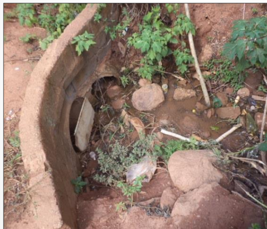
Créditos: Natália Lopes – CPRM/SGB Manilhamento entupido Local: Iapu - MG
