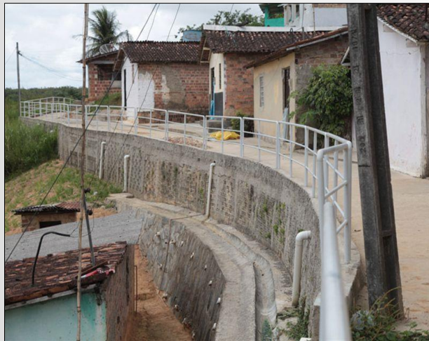
Foto: Prefeitura de Jaboatão dos Guararapes/PE. Acesso em região íngreme com contenções e drenagem.
