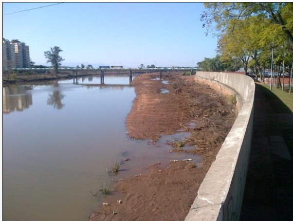
Fonte: < https://semgravata.wordpress.com > Dique marginal, São Leopoldo – RS.
