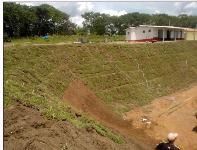
Proteção da face do talude com gramíneas.
