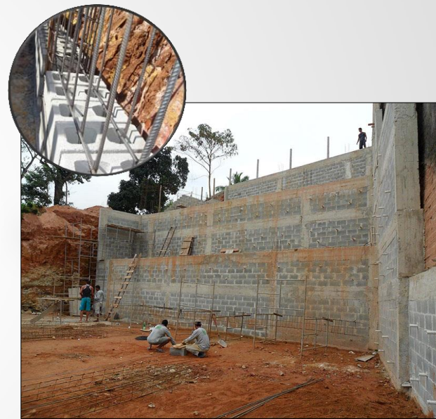
Fonte: projetos.habitissimo.com.br Muro de arrimo
