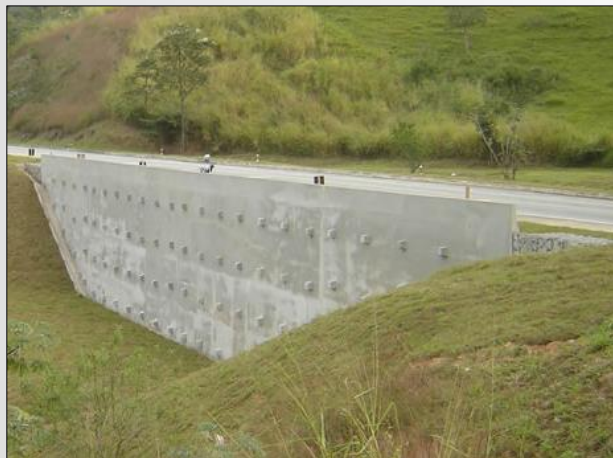
Créditos: SOPE Engenharia Cortina atirantada
