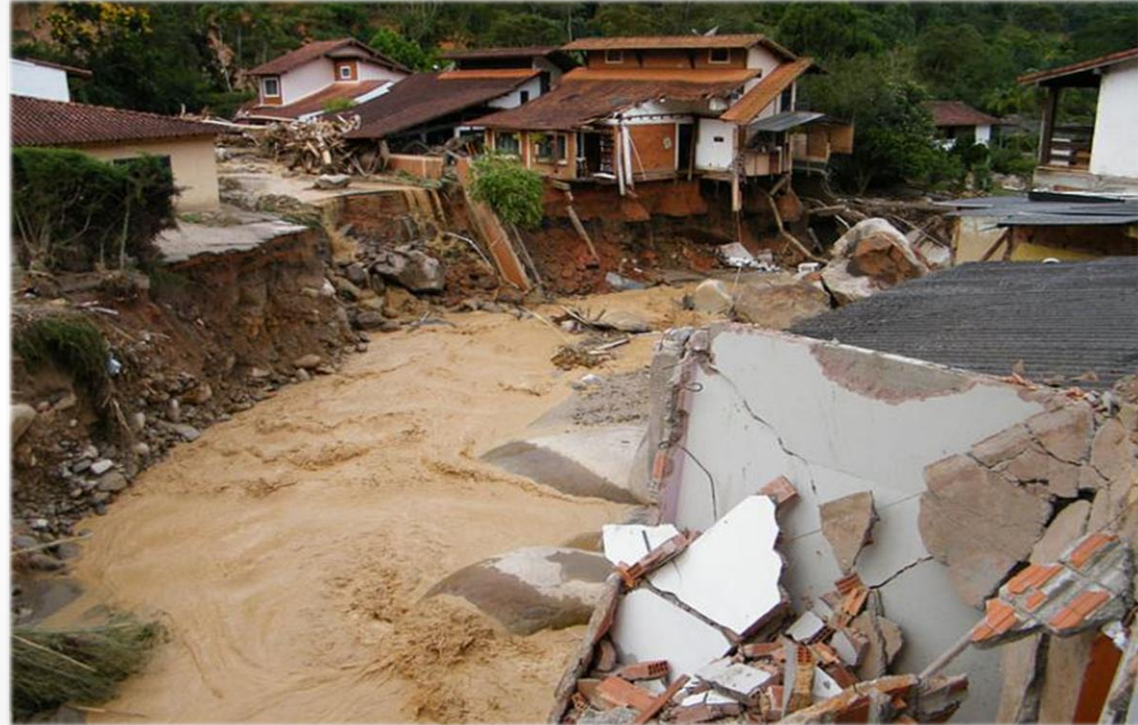
Enxurrada com solapamento de margens
