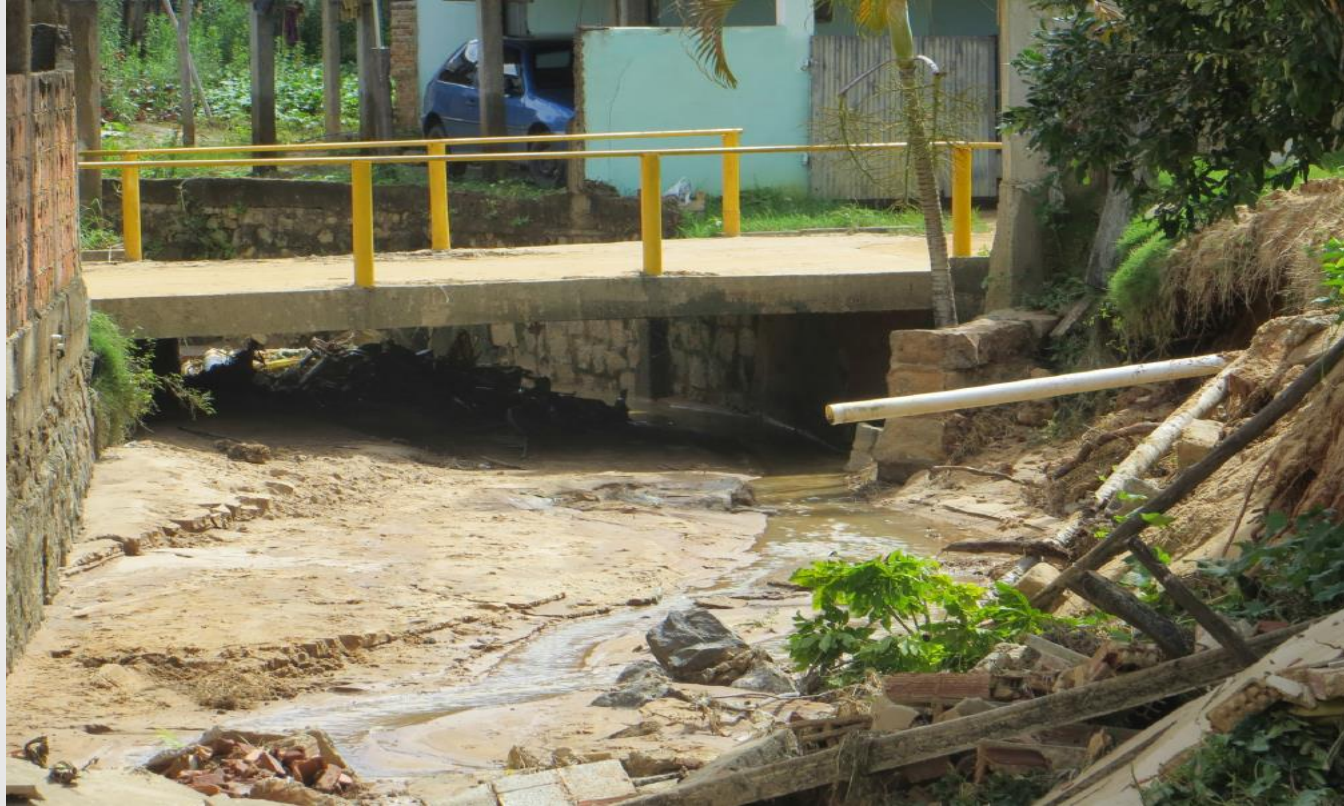
Assoreamento de canal de drenagem
