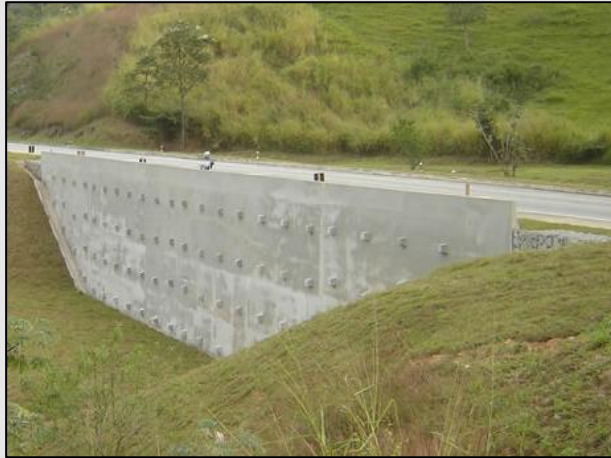
Cortina Atirantada Créditos: SOPE Engenharia
