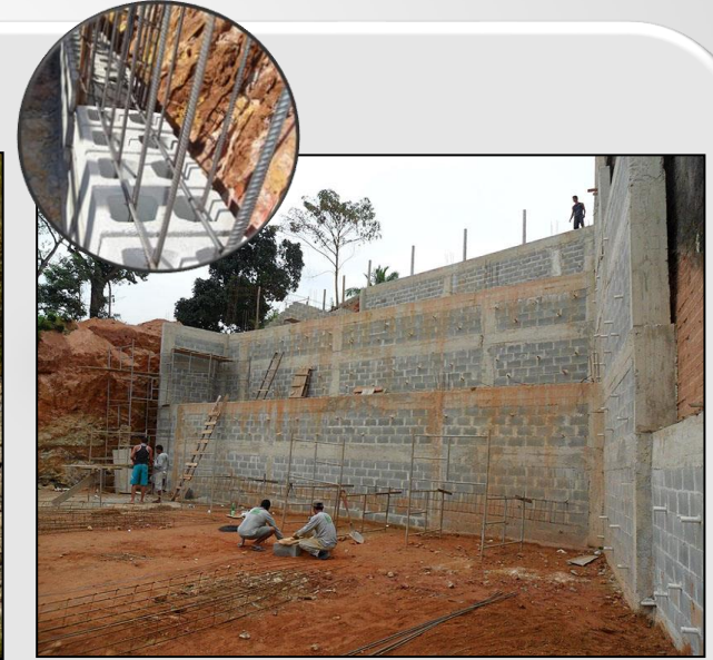
Muro de arrimo Fonte: projetos.habitissimo.com.br
