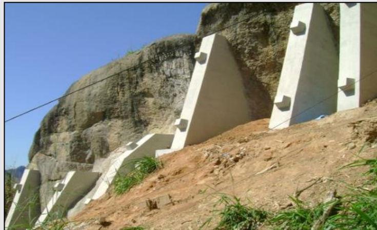
Uso de contraforte Crédito : Defesa Civil do Espírito Santo
