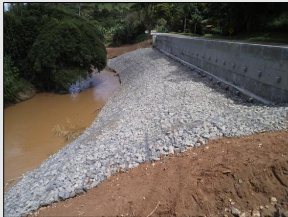
Enrocamento contra erosão Créditos: SOPE Engenharia
