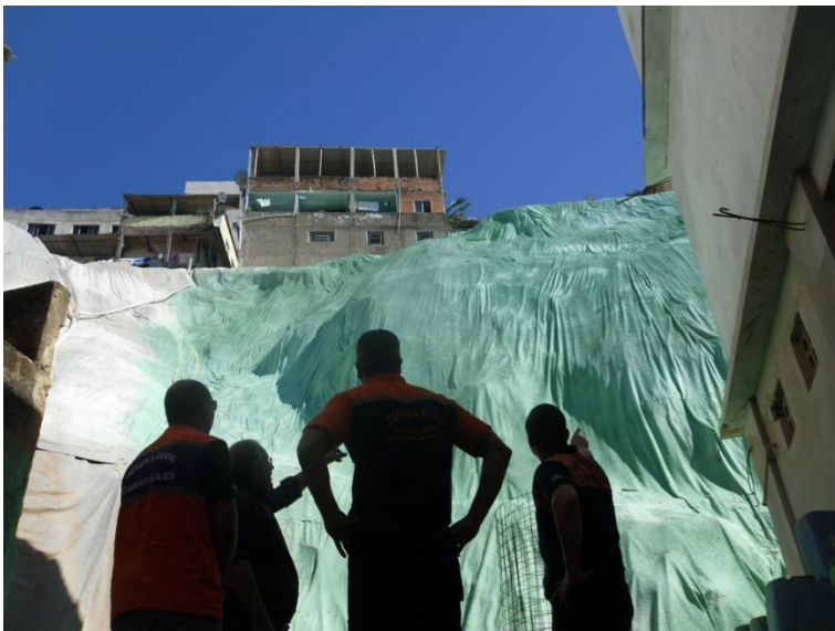
Estabilização de talude c/Geomanta Sotelândia - Cariacica/ES – Feb/2015
