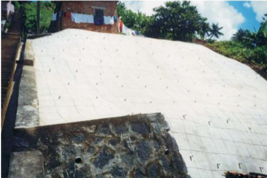
REVESTIMENTO COM TELA ARGAMASSA Camaragibe
