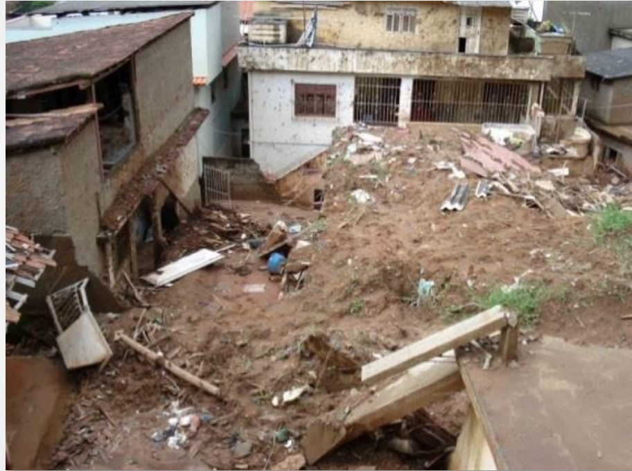
Deslizamento ocorrido no Bairro Floresta, em Nova Friburgo, que atingiu moradias ocasionando vítimas fatais ( Jan/2007 )
