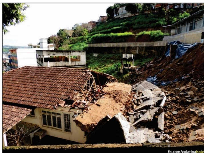
Figura 20: Deslizamento em Colatina - Dezembro de 2013. Fonte: fb.com/colatinahoje .
