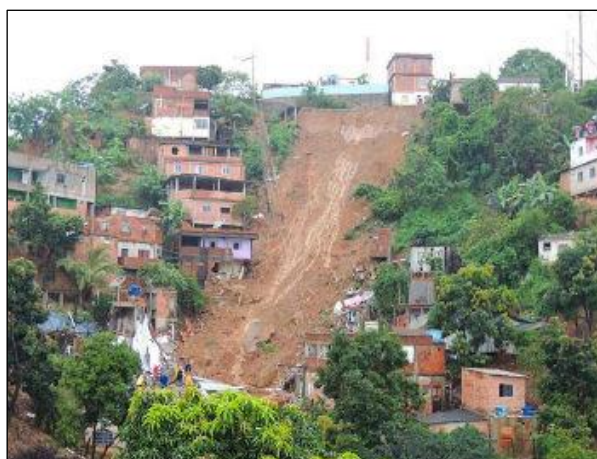
Figura 1: Deslizamento de terra em Colatina/ES durante as chuvas de dezembro de 2013. Fonte: Jornal on-line Folha Vitória 1 .
