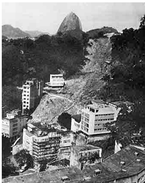
Fig. 23 – Enchentes na Guanabara - Rio de Janeiro – 20/01/1967 – Desabamento Edifícios Rua General Glicério – 200 mortos 300 feridos
