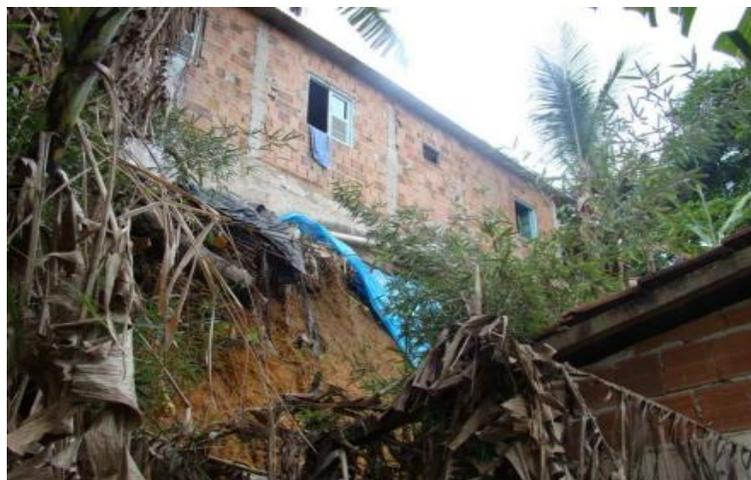
Foto 05: Área de risco com talude de corte vertical (-90°), com risco R4. Fonte: CPRM 2012
