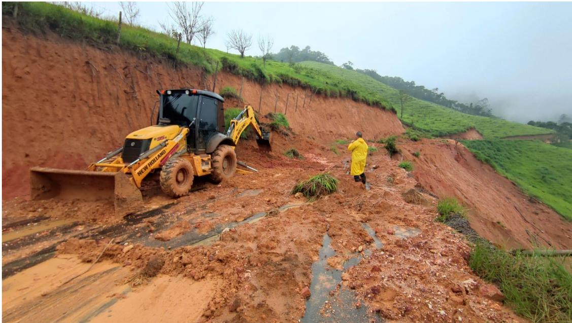
Foto 08: Deslizamento rotacional em estrada vicinal. Fonte: COMPDEC
