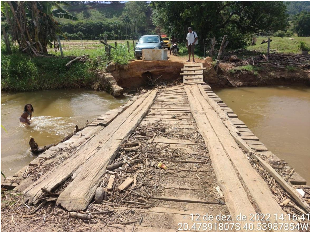
Foto 11: Desmoronamento de ponte de madeira, utilizada em área rural de Guarapari. Fonte: COMPDEC
