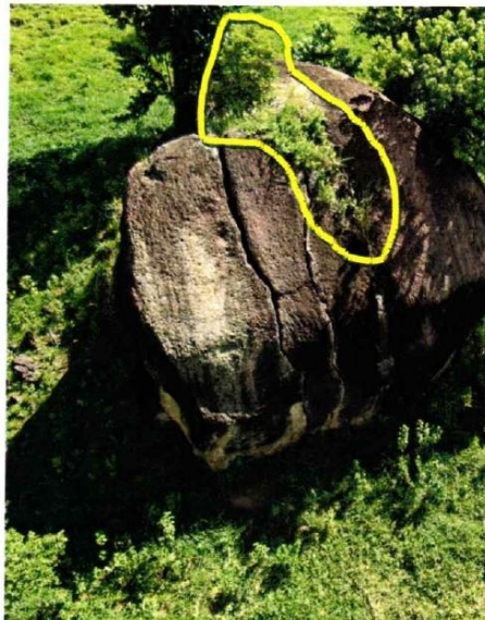
FOTO 03 (DRONE) – Vista parcial superior do bloco rochoso vistoriado onde se observa a presença de vegetação (polígono amarelo) inseridas nas fraturas.
