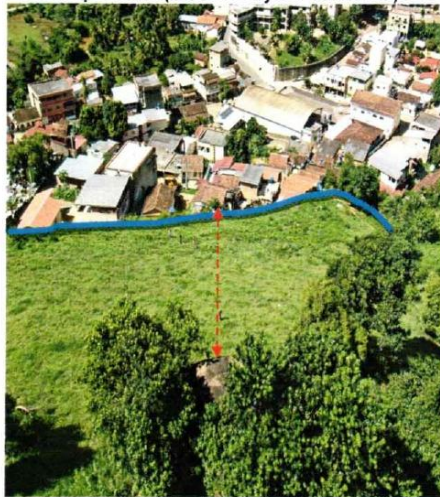
FOTO 07 (DRONE) – Linha azul claro mostra a delimitação entre a área residencial e o bloco vistoriado; distância aproximada de 63,0 m entre o bloco e o imóvel mais próximo (linha tracejada vermelha).
