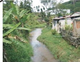
Casas em situação de risco alto, na planície de inundação do rio Novo
