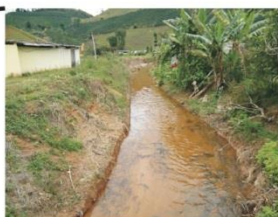
Trecho onde foi executada obra de dragagem do leito do rio
