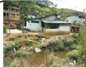
Solapamento da margem do rio
