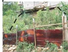
Cicatrizes de deslizamentos em aterros lançados sem medidas de estabilização
