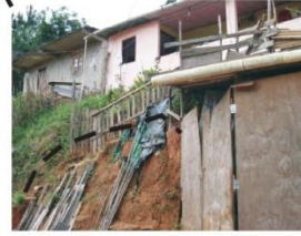
Cicatrizes de deslizamentos em aterros lançados sem medidas de estabilização
