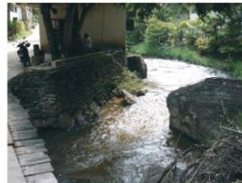
Estreitamento do rio, provocado por construção inadequada
