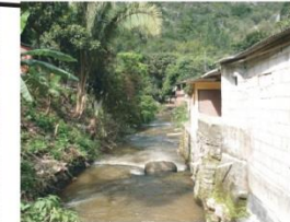
Casas situadas no leito do rio
