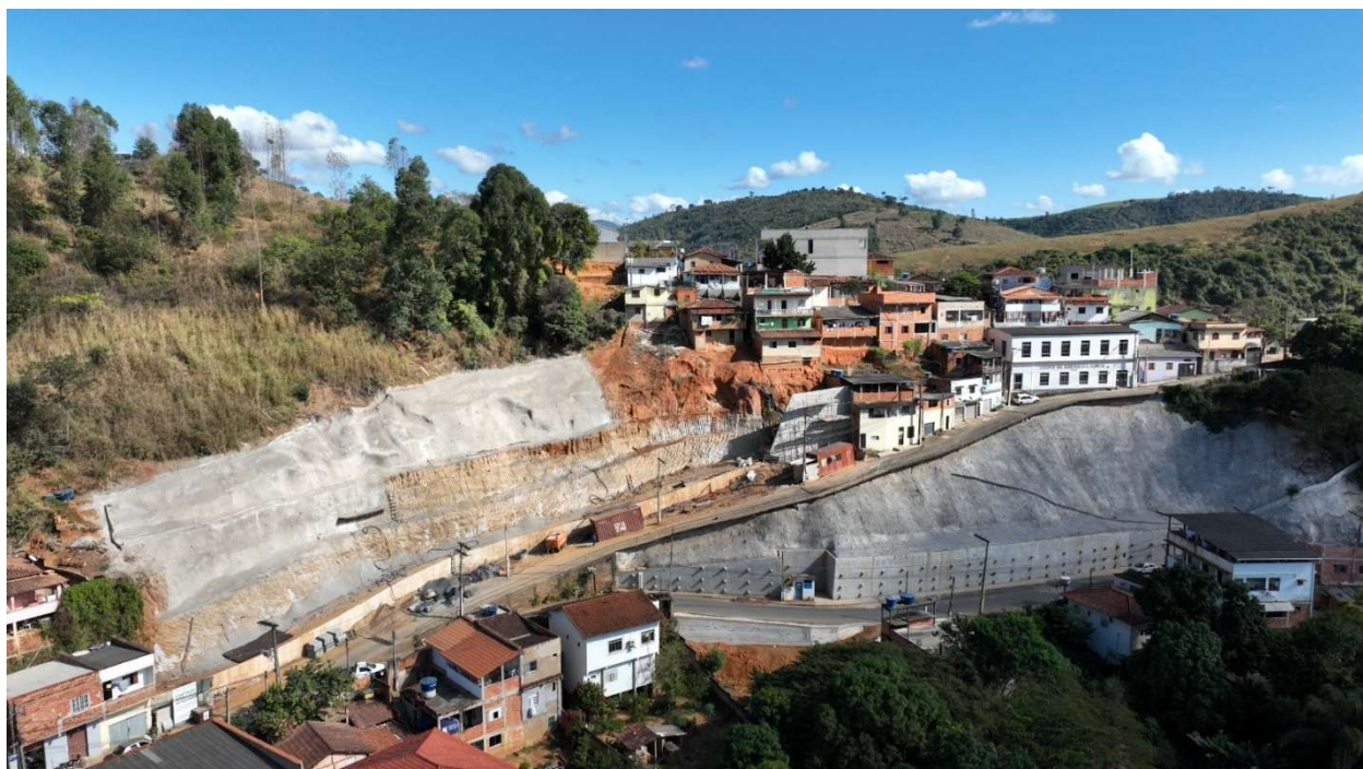
Muro de contenção em fase de construção
