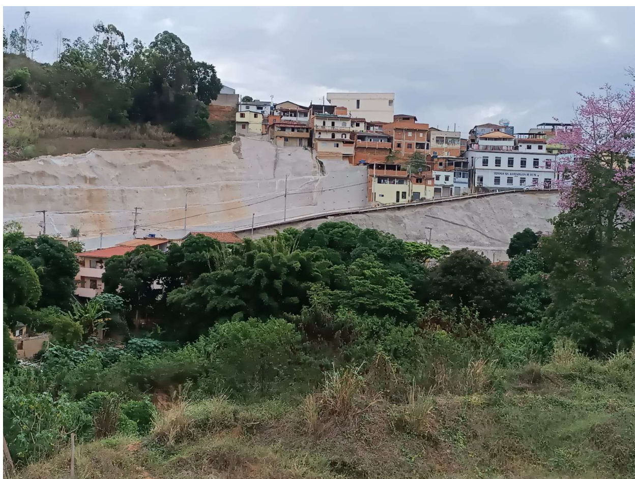
Muro de contenção construído
