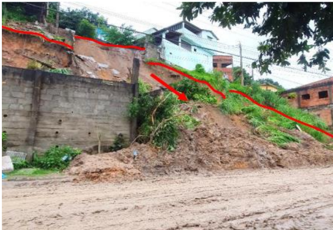
Ponto 05 – Escorregamento com soterramento da Avenida Cricaré
