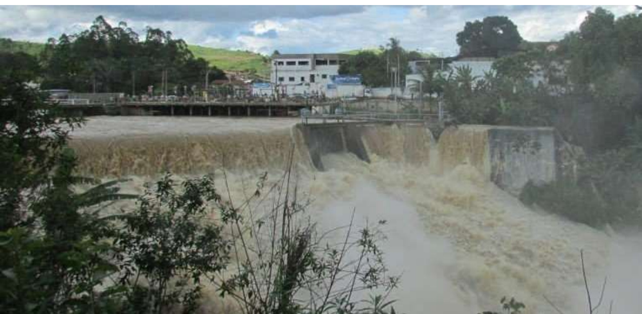
Foto: Enchente DEZEMBRO/2013 - Barragem de Geração de Energia - Cachoeira da Onça São Gabriel da Palha/ES
