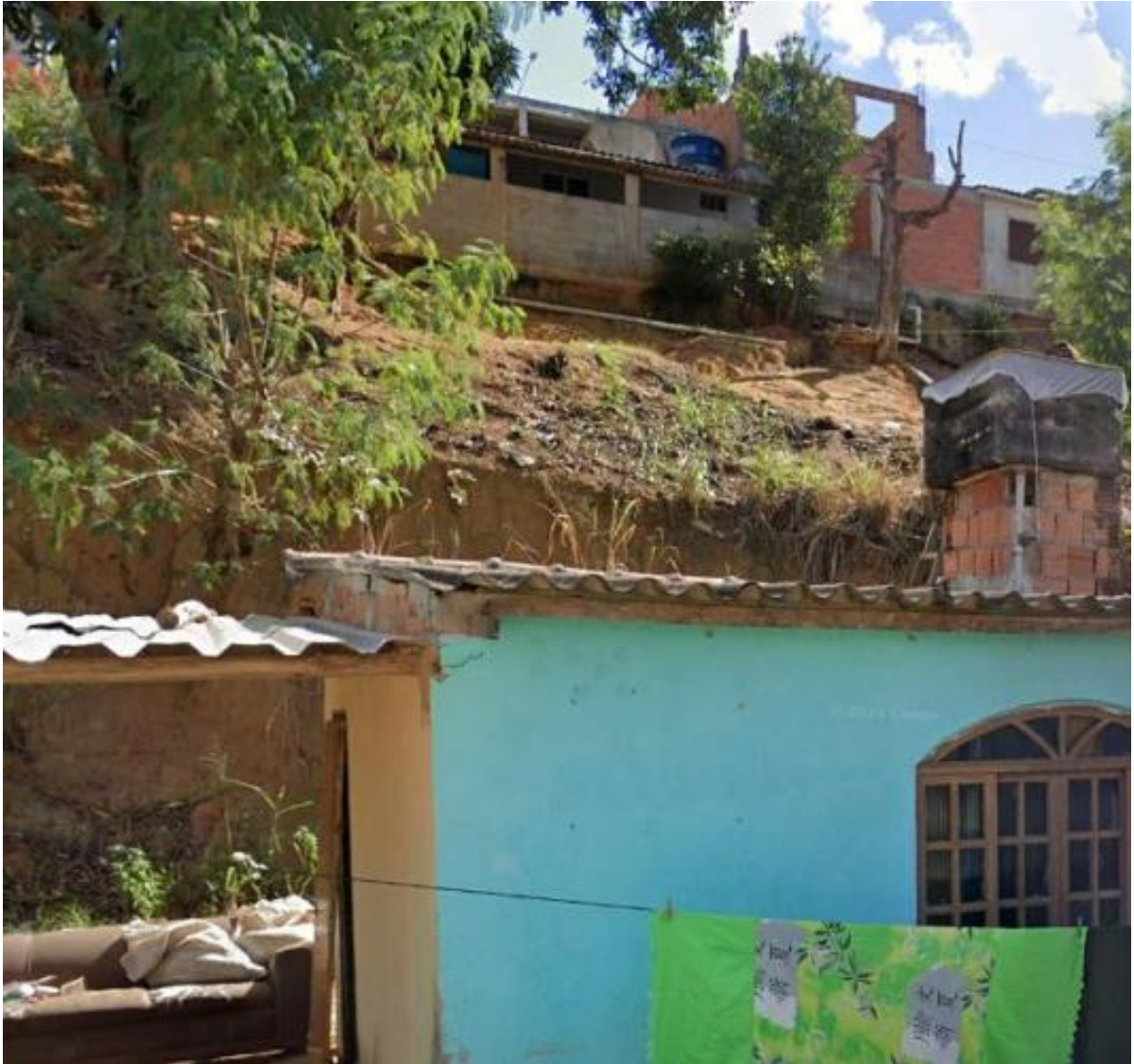
Figura 19: Vista parcial do Setor 03. Imagem Google, 06/2024. Fonte: PMRR/2025
