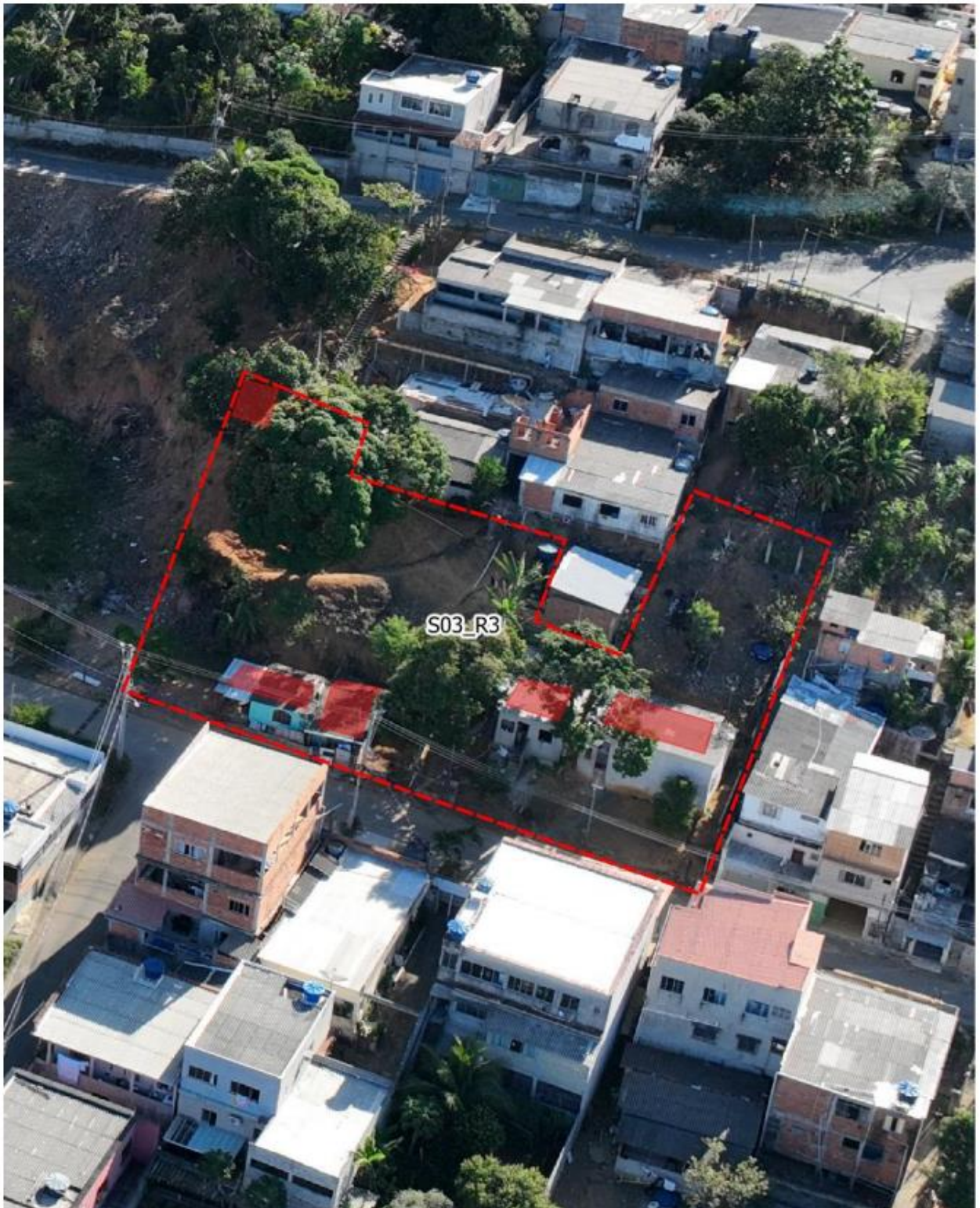
Figura 18: Vista panorâmica do Setor 03. Fonte: PMRR/2025
