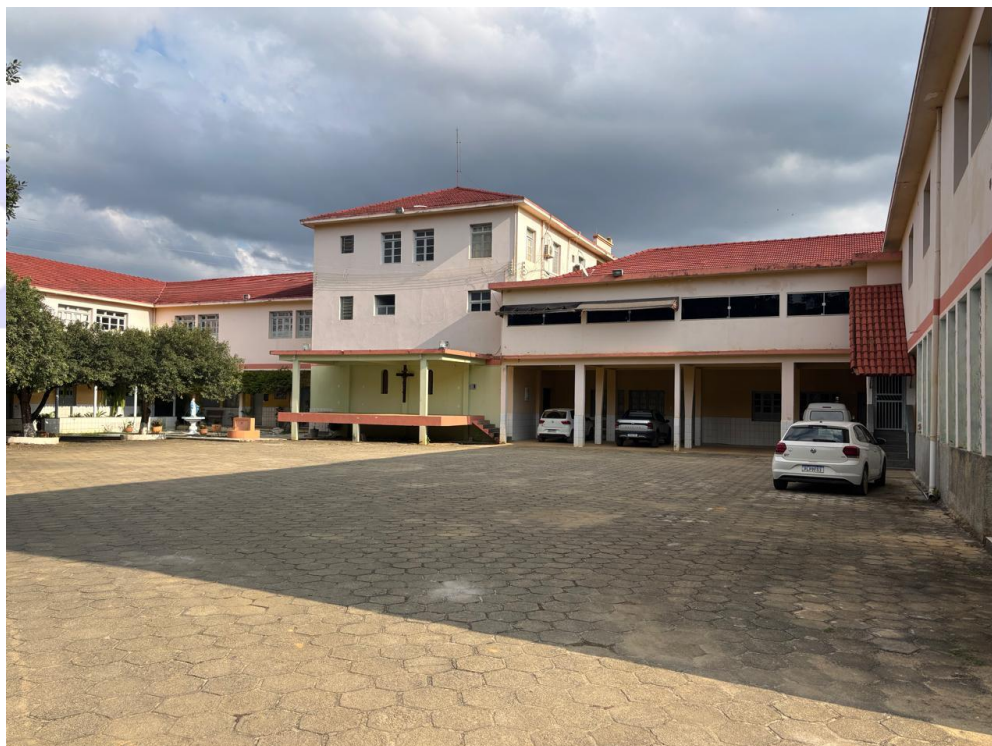
Imagem 02 – Vista dos aspectos estruturais da edificação-sede mobilizada para o estabelecimento do Posto de Comando (PC). O complexo apresenta características táticas favoráveis, como amplitude espacial para o desdobramento logístico, facilidade de controle de acesso e capacidade de centralização das agências de resposta multissetoriais envolvidas na operação.
