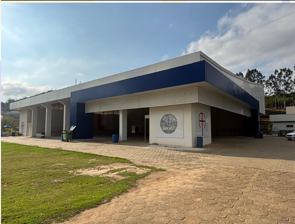
Imagem 03 – Vista da Área de espera e zona de transição humanitária para a gestão de riscos e Desastres. O complexo apresenta pátio pavimentado adjacente com acessibilidade para o vetoramento de ambulâncias e ônibus de resgate, enquanto a área interna coberta atua como plataforma de estabilização e triagem de desalojados antes do encaminhamento para os abrigos temporários de longa permanência.
