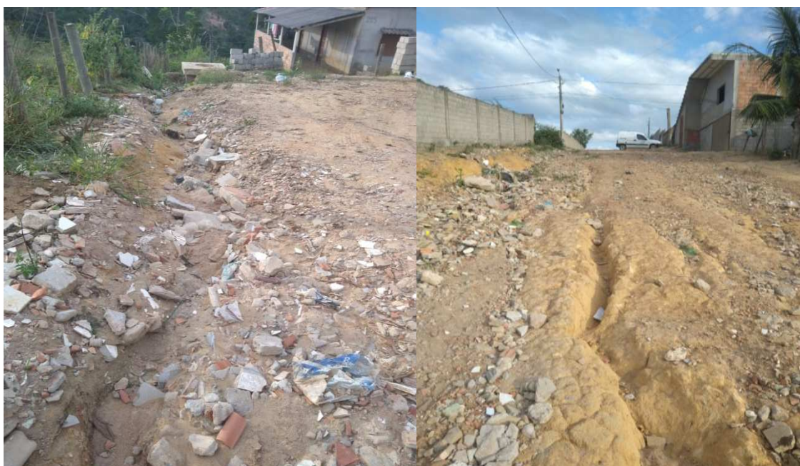
Foto 52 e 53: Rua Jasmim e Bela Vista - Bairro Eldorado, trecho onde ocorre enxurradas e erosão. Coordenadas: 18.29106081S 39.96628813W.
