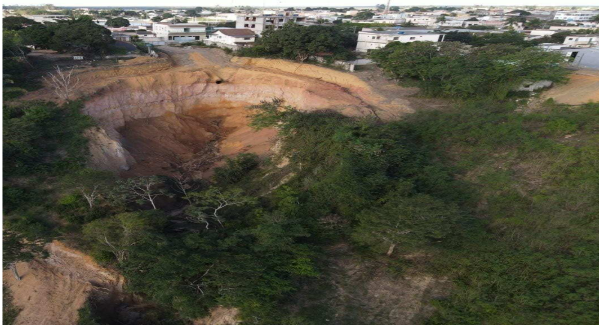
Foto 05: Áreas de risco. Bairro N. Horizonte. Avanço da erosão após as chuvas dezembro/2022.
