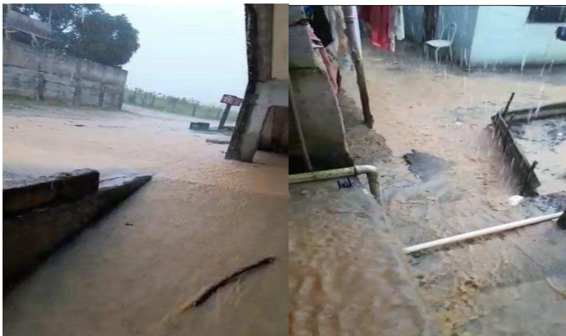
Foto 50 e 51: Rua Elcio Alvarez e Rua Jasmim, Bairro Eldorado, trecho onde ocorre enxurrada e alagamentos em algumas casas. Fonte: COMPDEC/PC.
