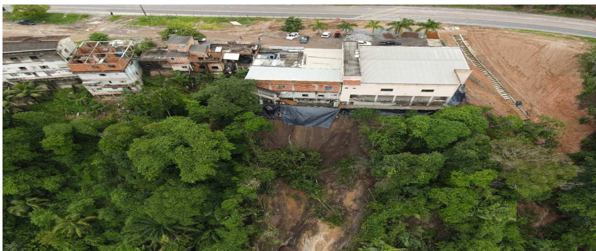
Foto 12: Escorregamento na encosta nos fundos dos imóveis e escadaria ECO101. Dezembro/2022
