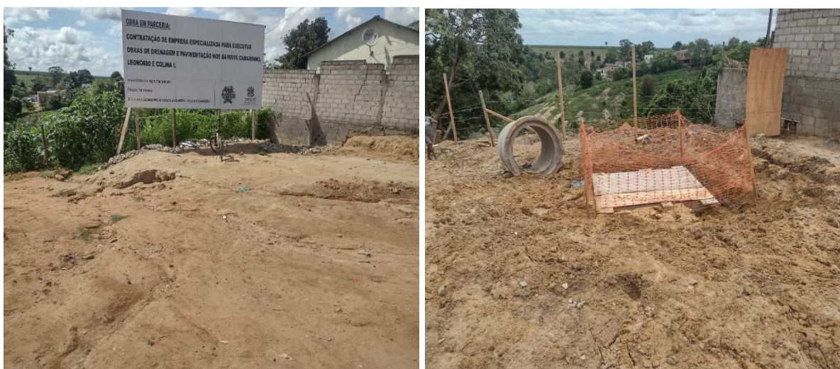
Foto 03 e 04: Rua Pedro Canário Ribeiro, Bairro Canarinho. Execução da obra de desvio da drenagem pluvial. Foto: 2024/2025
