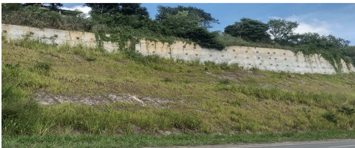
Foto 11: Ponto 01 local ocorreu escorregamentos da encosta em 2022. Em 2023 foi concluído a obra de contenção cortina atirantada pela ECO11. Foto abril/2025, UTMN 7.975.508m, E 398.857m.
