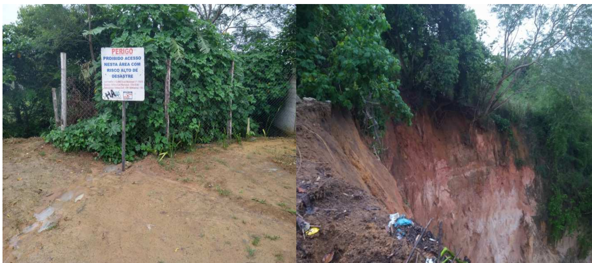
Foto 01 e 02: Rua Pedro Canário Ribeiro, Bairro Canarinho. Área de risco onde ocorre enxurradas, erosão e movimento de massa. Foto após as chuvas dezembro 2022.
