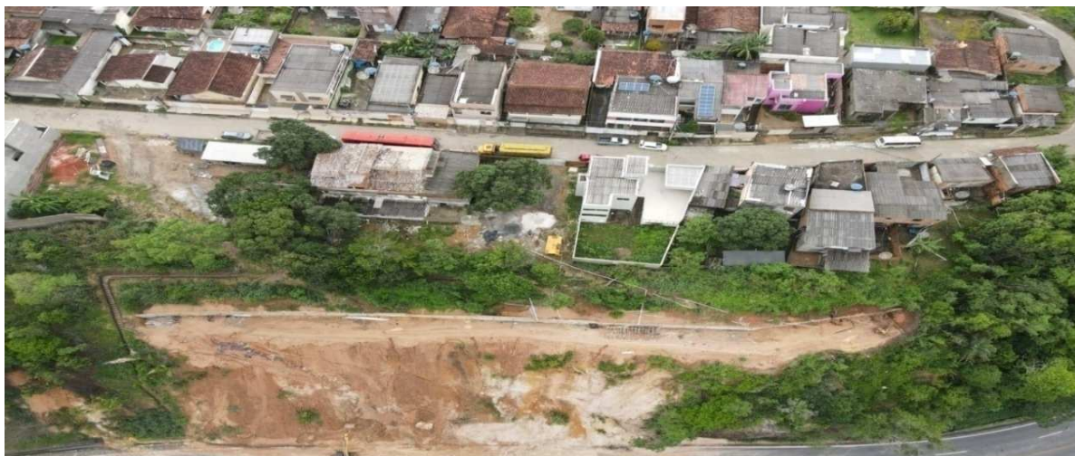
Foto 10: Ponto 01 de escorregamentos da encosta na margem da BR101 e obra de contenção cortina atirantada, dezembro 2022. (ECO11). UTMN 7.975.508m, E 398.857m.
