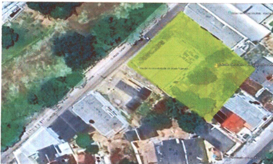
Descrição SR-30 – Rua Santa Tereza – Bairro Beira Rio: talude natural foi realizado um talude de corte, sem estruturação para ocupação residencial, colocando varias residências em risco, sem qualquer obra de drenagem pluvial ou escoamento superficial, sem obras de contenção, risco de movimento de massa.
