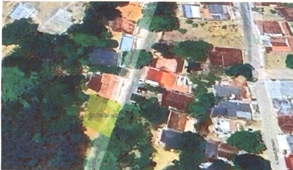
Descrição SR-29 – Rua José Zamprognó – Bairro Municipal I: talude natural foi realizado um talude de corte, sem estruturação para ocupação residencial, sem qualquer obra de drenagem pluvial ou escoamento superficial, sem obras de contenção, risco de movimento de massa.
