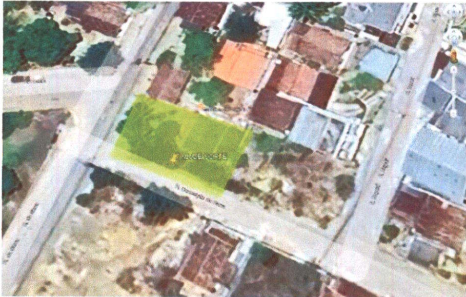
Descrição SR-31 – Rua Serra/Conceição da Barra – Bairro Iolanda: talude natural foi realizado um talude de corte, sem estruturação para ocupação residencial, sem qualquer obra de drenagem pluvial ou escoamento superficial, sem obras de contenção, risco de movimento de massa.
