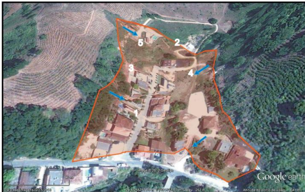
Figura 14: Áreas suscetíveis a deslizamentos de massa no município no bairro Goiabão.
