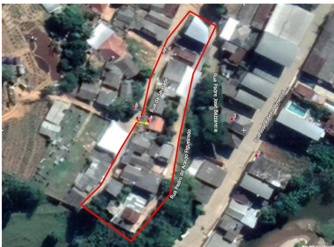
Figura 17 - mapeamento da área de risco à deslizamento planar no Distrito de Menino Jesus, realizado pelo SGB no ano de 2023. Fonte: Carta de suscetibilidade do SGB.
