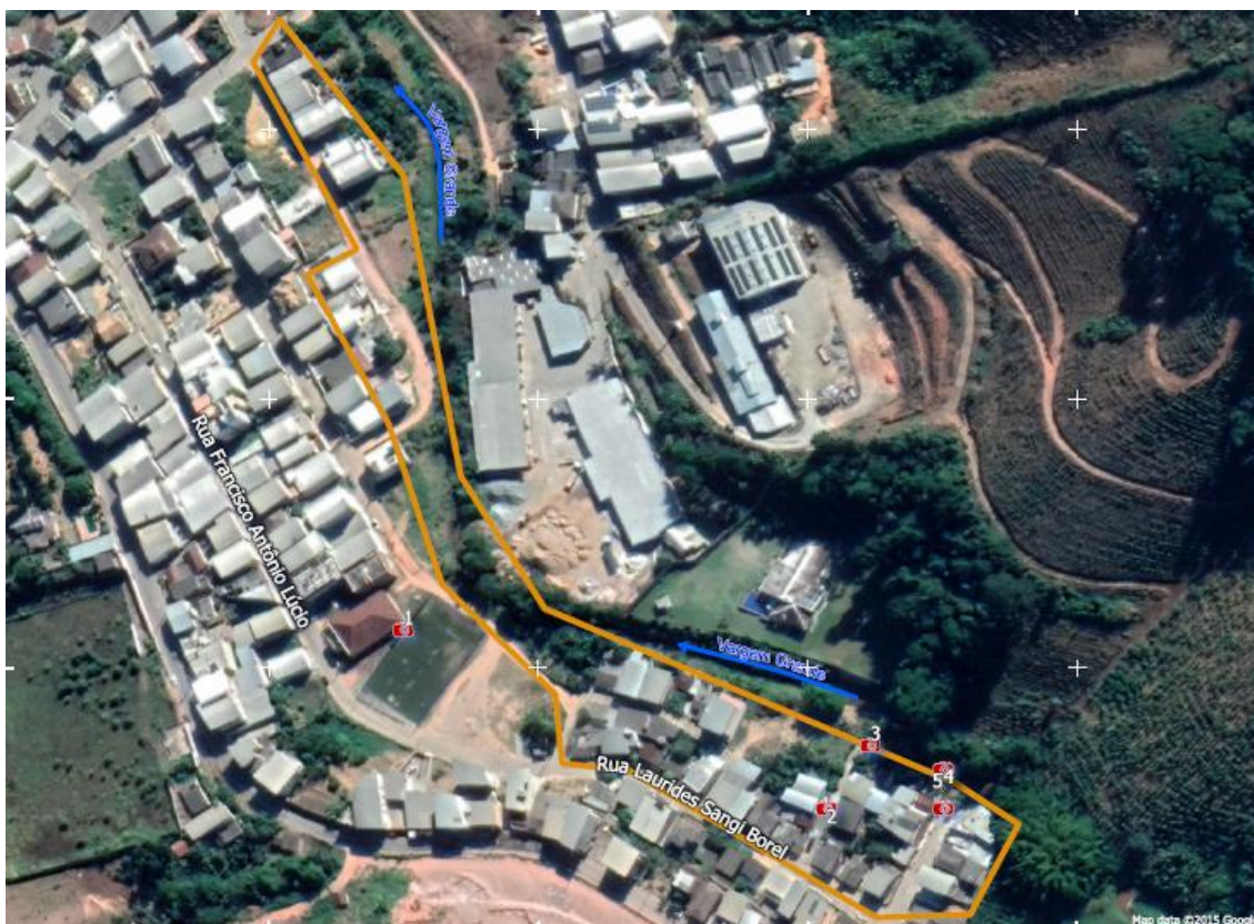
Figura 13 - mapeamento da área de risco do Bairro Santa Terezinha realizado pelo SGB no ano de 2023.
