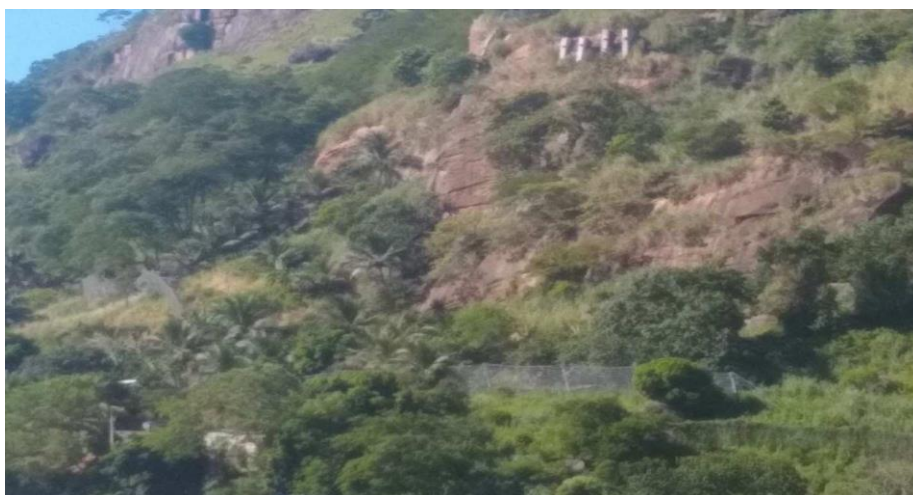
Fotos: Obra de contenção Morro do Cristo - 2020
