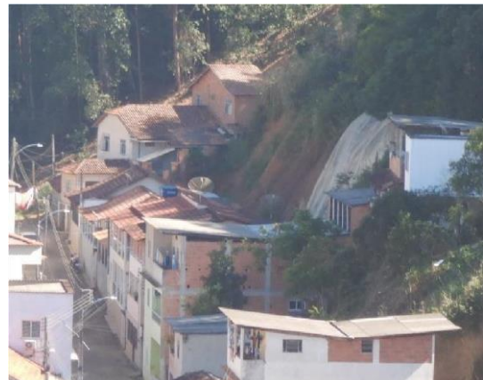
Figura 5 – Construções próximas do talude de corte na sede municipal.
