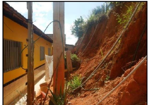
Figura 9 – Talude de corte no Distrito de Sapucaia
