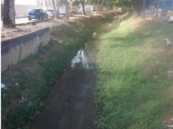
Figura 14 – Construção em planície do Córrego da Prata
