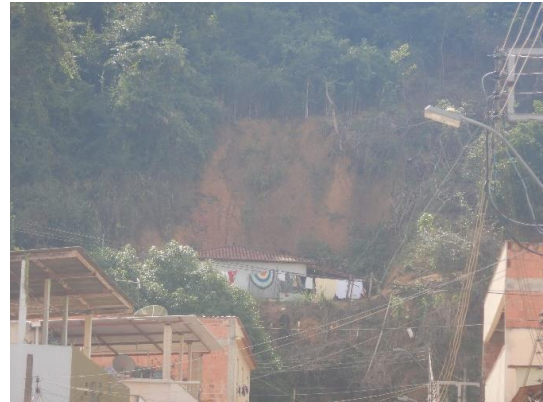
Figura 7 – Talude de corte atrás de moradia.
