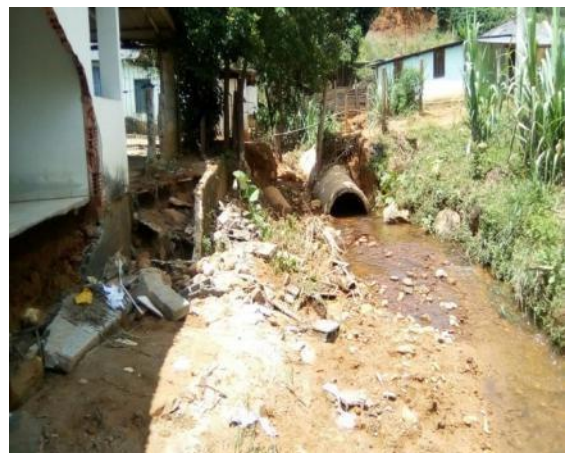
Após uma chuva forte, as manilhas não suportaram a vazão que ocorreu, com a correnteza forte carregando parte de uma construção, na cabeceira Santa Marta, no ano de 2018.
