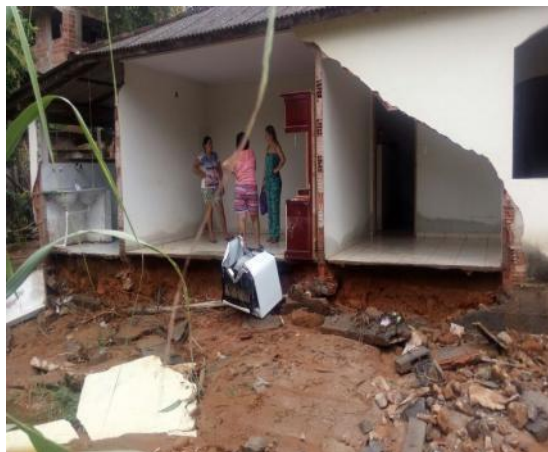
Após uma chuva forte, as manilhas não suportaram a vazão que ocorreu, com a correnteza forte carregando parte de uma construção, na cabeceira Santa Marta, no ano de 2018.
