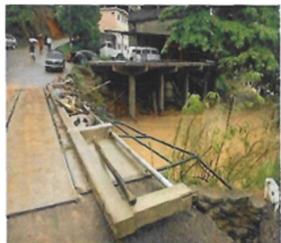
Foto 22: Ponte sobre o Rio Taquarassu – Bairro São Cristóvão.
