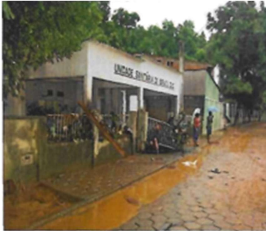
Foto 17: Unidade Sanitária de Ibiracu- Bairro Ericina.
