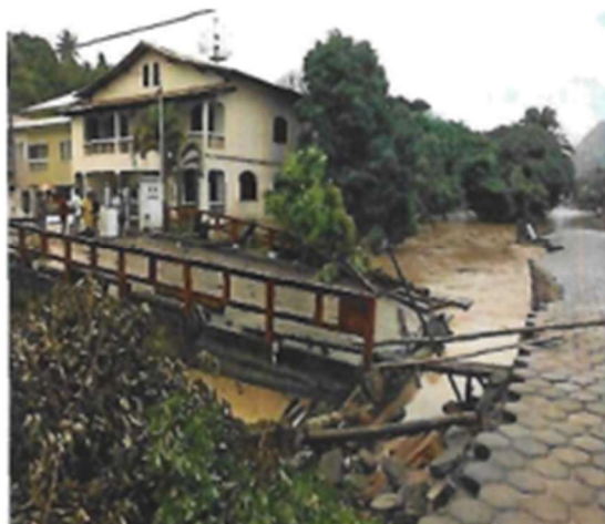
Foto 21. Ponte Sobre o Rio Taquarassu – Bairro Ericina.
