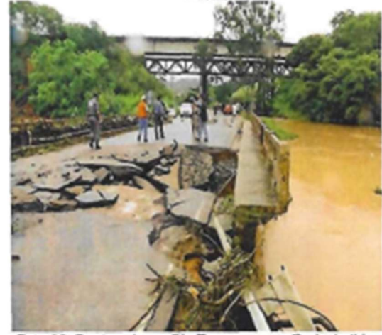
Foto 20: Ponte sobre o Rio Taquarassu – Rodovia Ibiracu X Aracruz.
