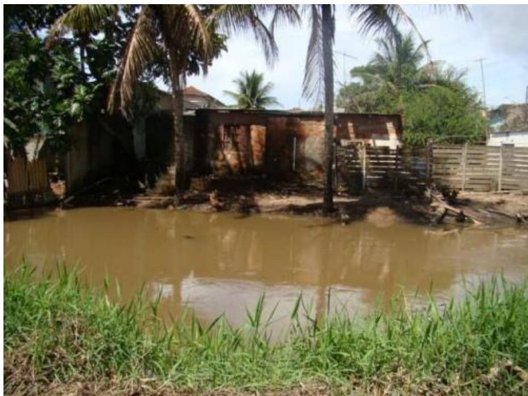
Foto 06: Área de risco de inundação, com risco R4. Fonte: CPRM 2012
