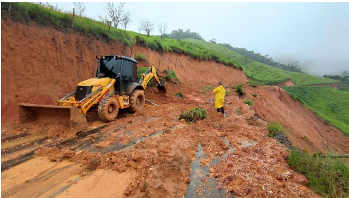
Foto 08: Deslizamento rotacional em estrada vicinal. Fonte: COMPDEC
