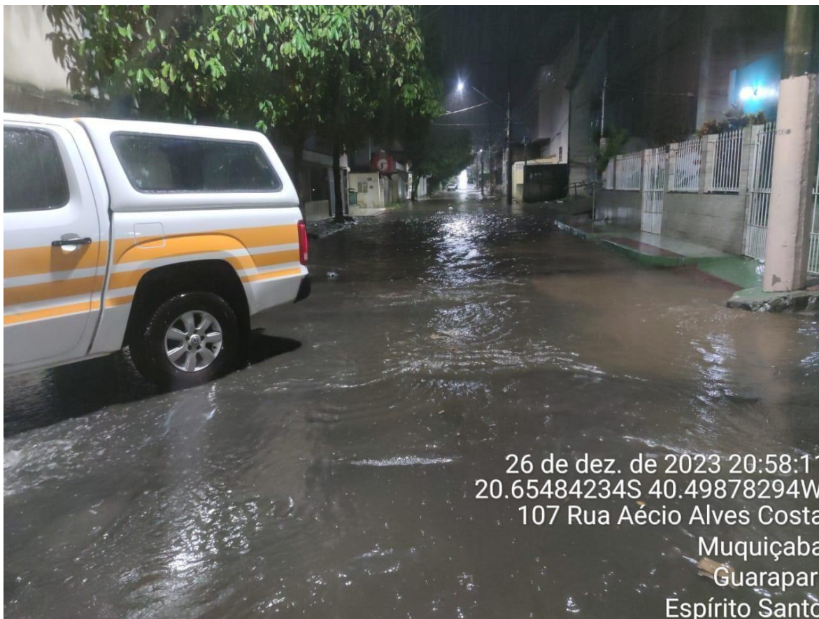
Foto 14: Após período de chuvas intensas, escoamento da água pluvial em via de acesso. Fonte: COMPDEC
