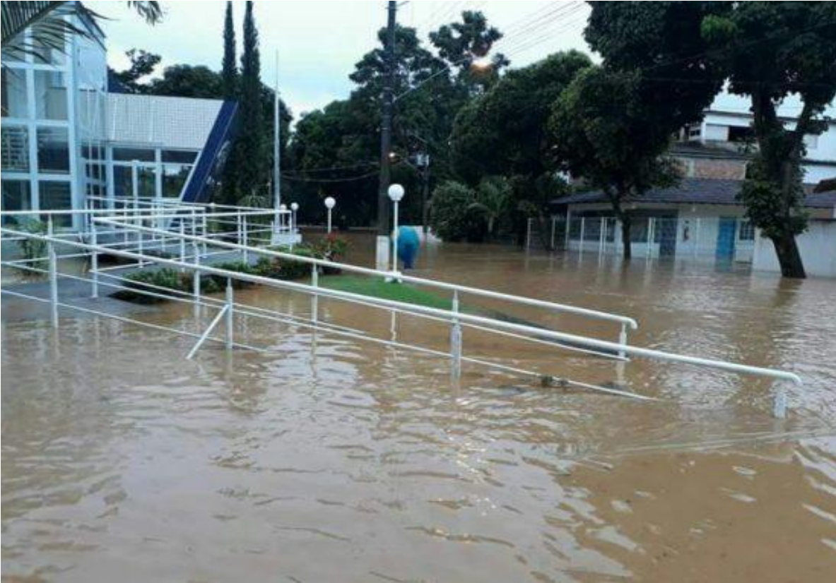
Foto 10: Alagamento causado por fortes chuvas em 2010. Fonte: Folha Online ES 2010
