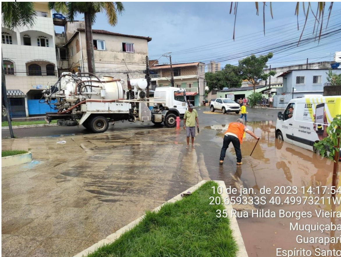
Foto 15: Ação da PMG para desobstrução do canal de escoamento pluvial. Fonte: COMPDEC
