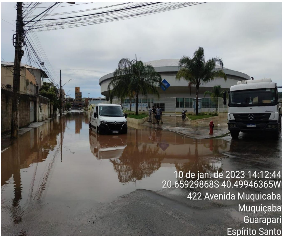
Foto 12: Avenida Muquiçaba alagada após chuvas Jan/2023. Fonte: COMPDEC
