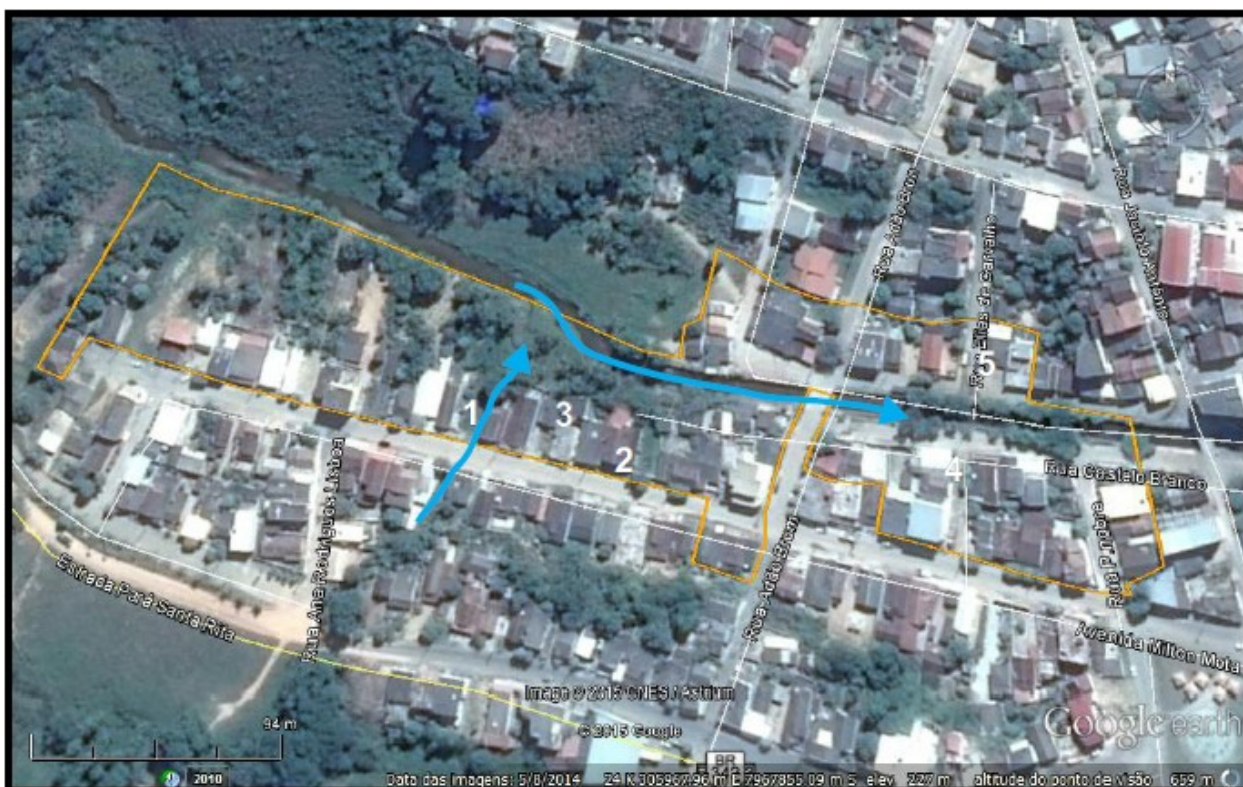
Imagem 04 – Polígono de risco denominado em relatório técnico do CPRM – 2015
