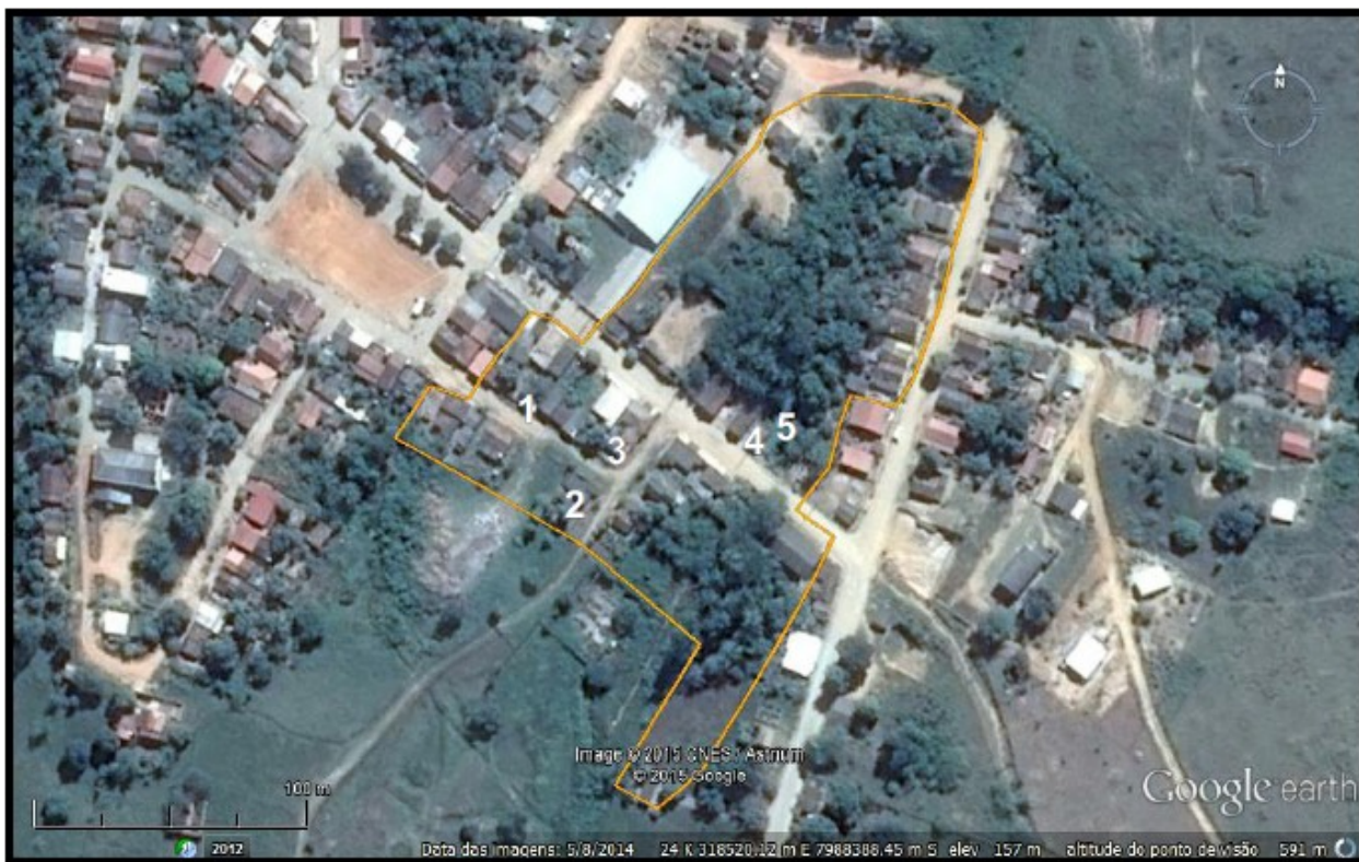
Imagem 02 – Polígono de risco denominado em relatório técnico do CPRM – 2015
