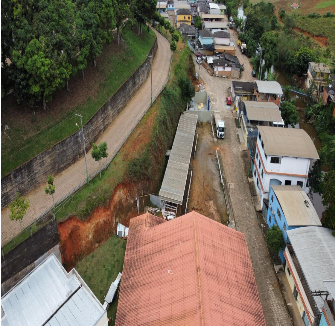
Foto 09: Muro de contenção ao lado do CRAS.
