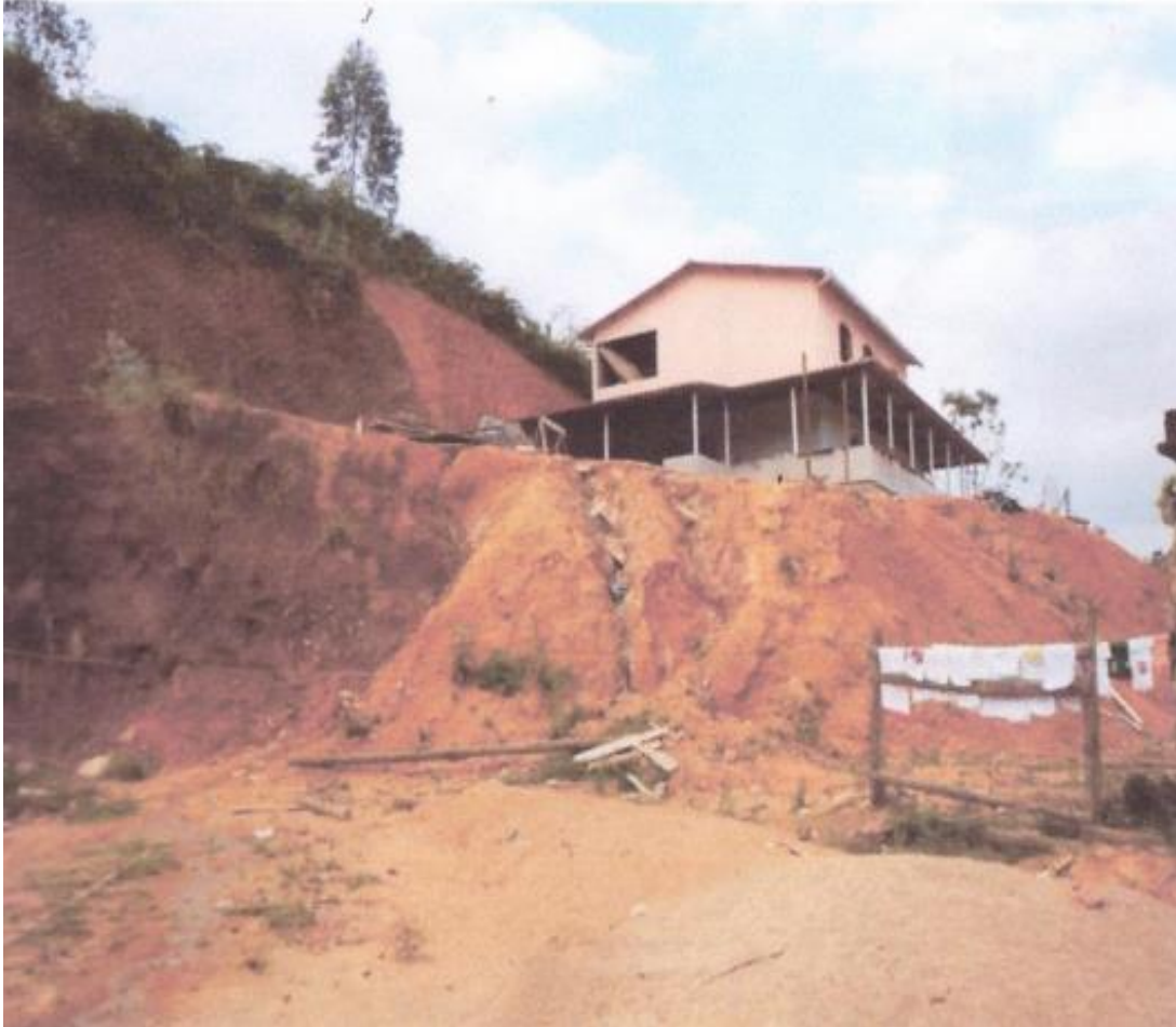
Foto 4: Imóvel em construção em corte e aterro.
