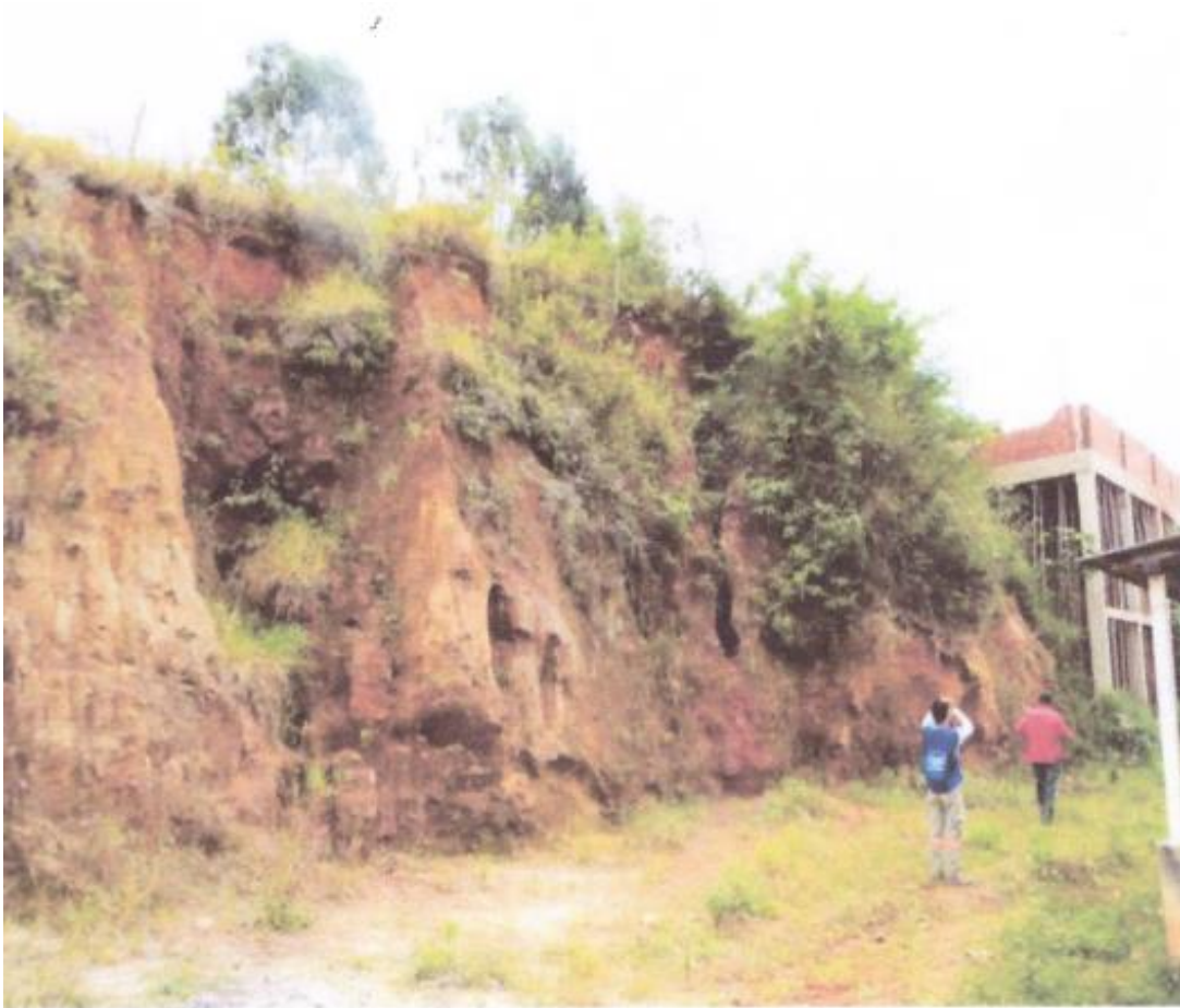
Foto 2: Talude atrás da escola onde houve o deslizamento.
