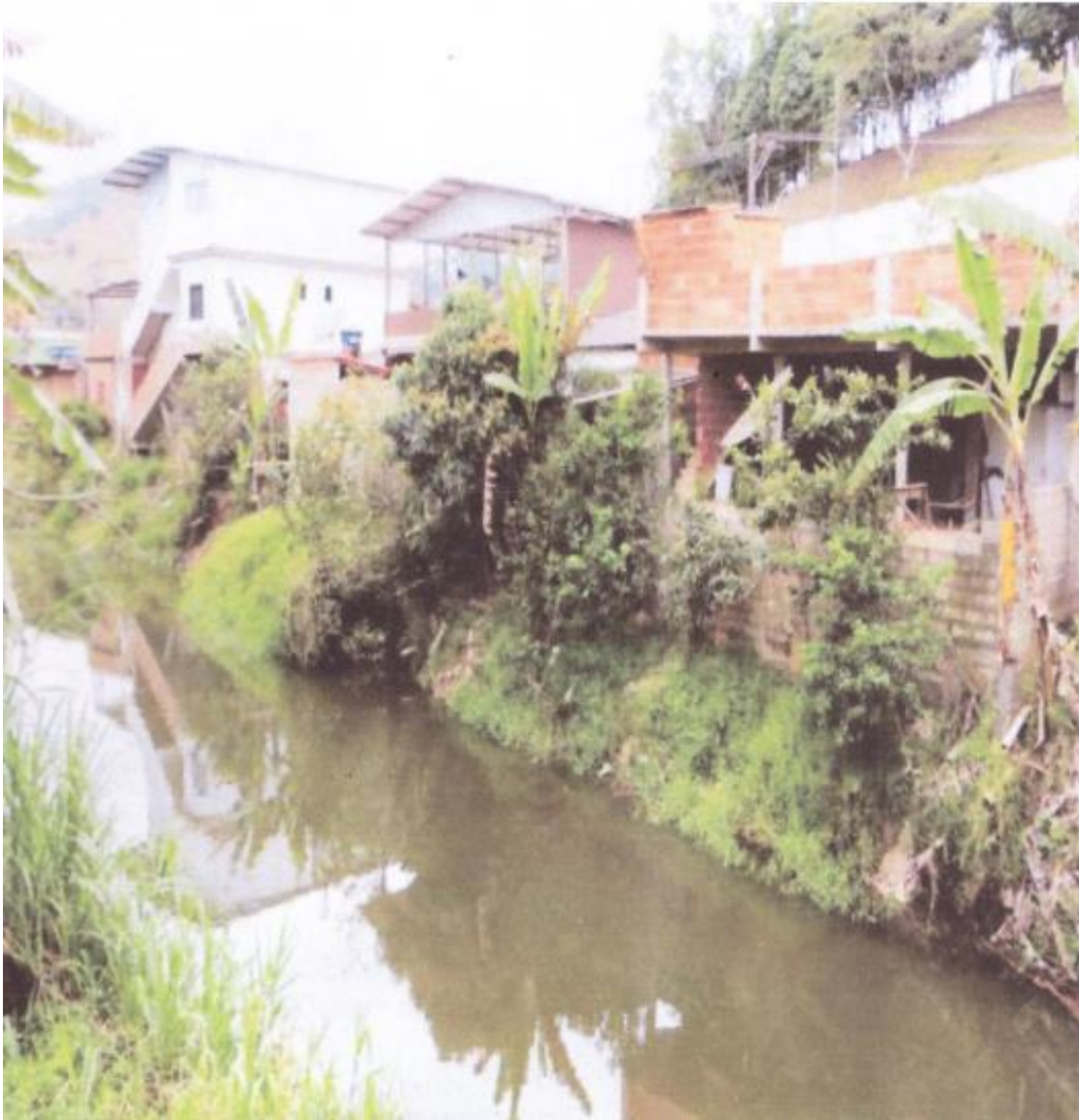
Foto 6: Moradias à margem do Rio Veado.
