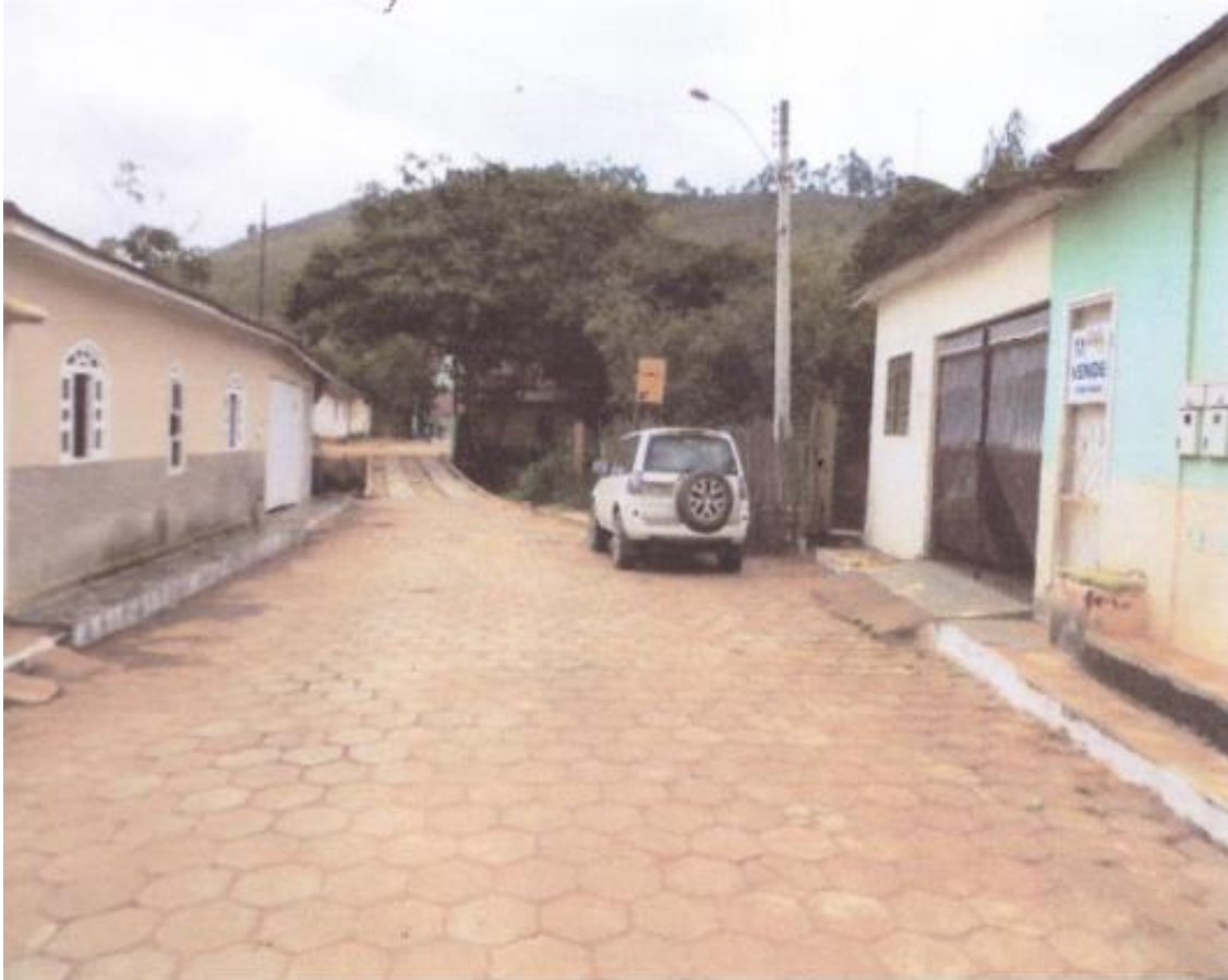
Foto 3: Região onde a inundação chega a aproximadamente 1 metro.
