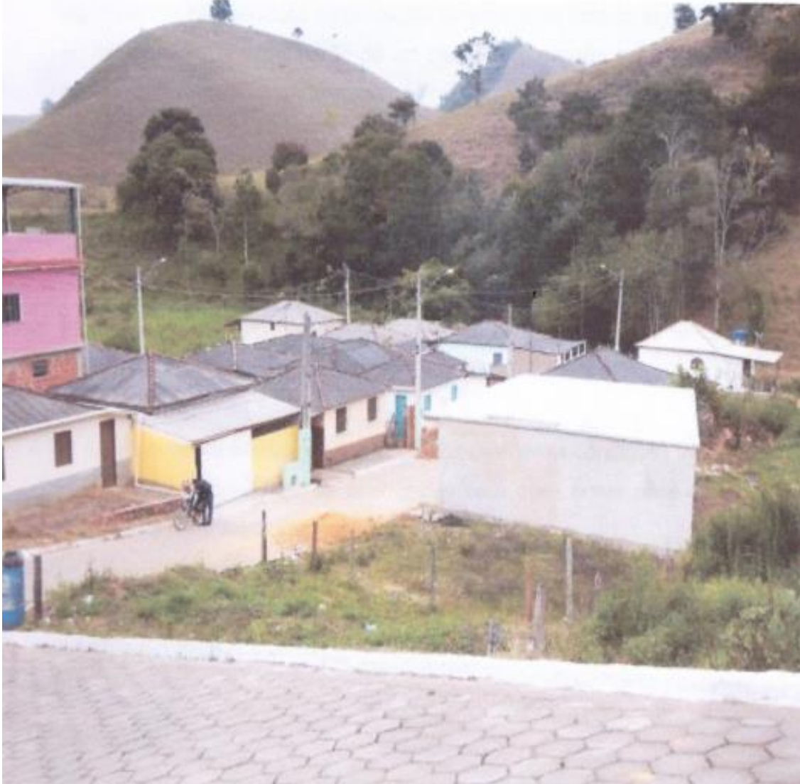
Foto 7: Moradias à margem do Rio Veado.
