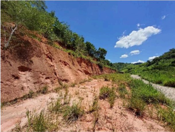
Figura 04 – Exposição de material siltico-argiloso em talude recente feito para instalação de novas edificações.
