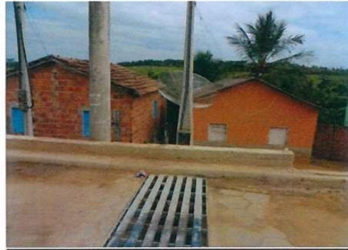
Figura 4: Estrutura de drenagem construída a montante das residências.
