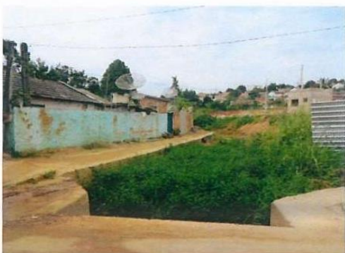
Figura 1: Planície de inundação do córrego Boa Esperança ocupada por residências, no setor ES_BES_SR_01_CPRM, na rua da Igualdade.
