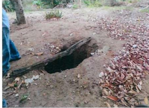
Figura 6: Uma das fossas existentes na encosta.
