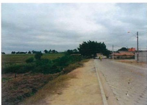
Figura 9: Vista geral das residências em área de risco.
