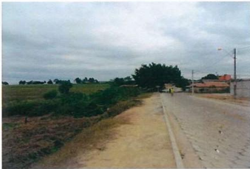
Figura 9: Vista geral das residências em área de risco.
