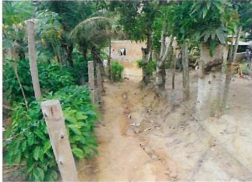
Figura 5: Caminho da água pluvial, gerando a enxurrada que atinge a moradia vista ao fundo.
