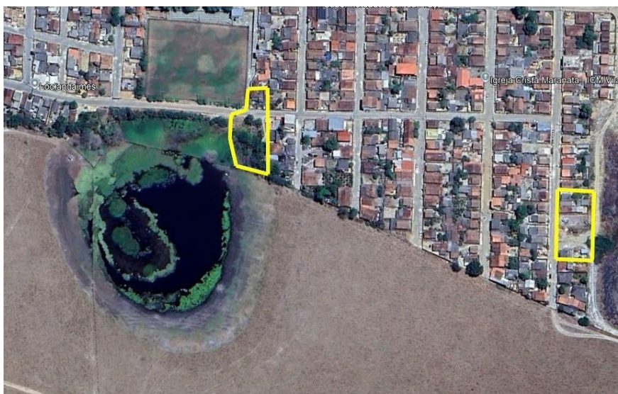
Figura 4 - Locais a serem monitorados nas ruas Jayme Barros e Tupinambás. Sujeitos a alagamentos.
