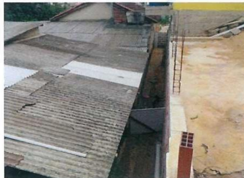
Figura 8: Muro de arrimo construído como contenção do maciço de solo acima de moradia.
